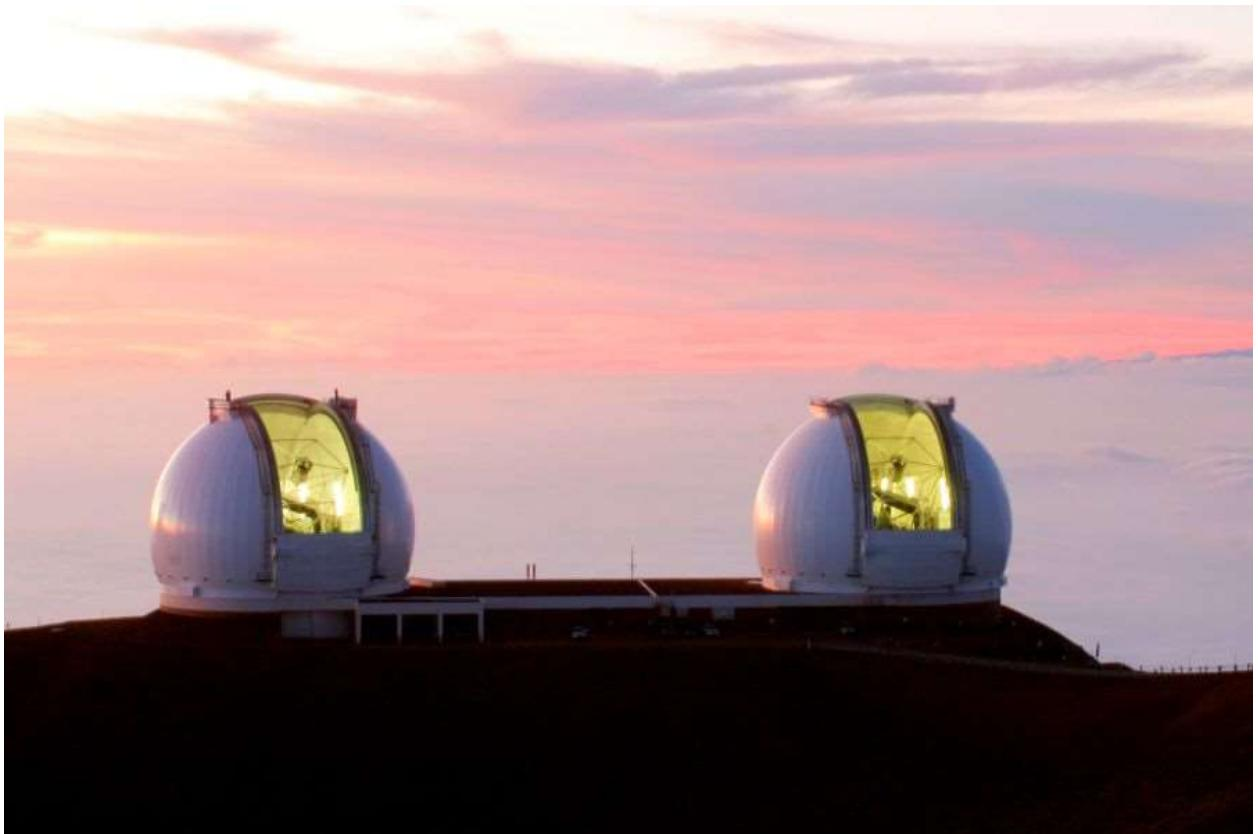
Оба этих американских телескопа соединены в одну систему (астрономический интерферометр) и могут работать вместе, создавая единое изображение. Уникальное расположение телескопов в одном из лучших мест на Земле с точки зрения астроклиматы (степень вмешательства атмосферы в качестве астрономических наблюдений) превратило Keck в одну из самых эффективных обсерваторий в истории.
