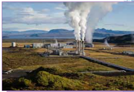
Мал. 3.12. Геотермальна електростанція Несьявеллір в Ісландії
