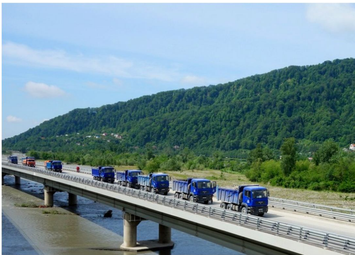
Рис. 4.4 - Випробування мостів динамічними навантаженнями
