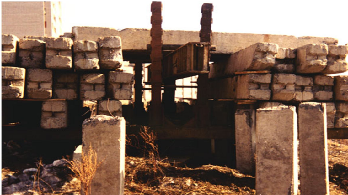
Рис. 4.1 - Випробування бурових паль статичними навантаженнями на ділянці будівництва
