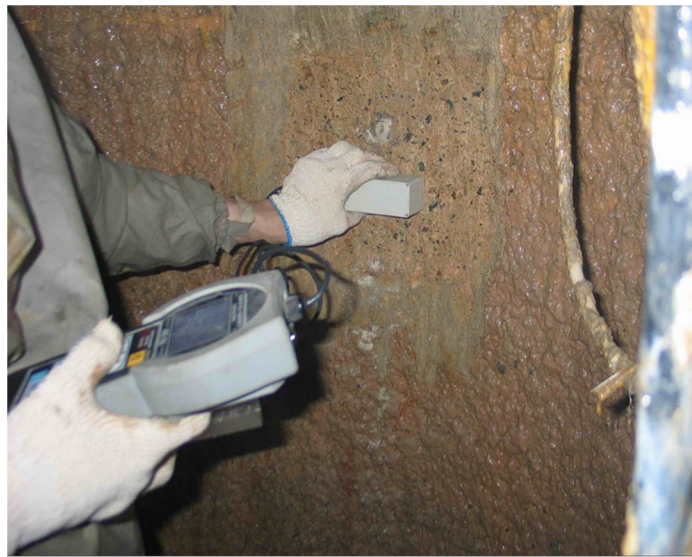
Рис. 3.29 - Визначення захисного шару бетону приладом ІЗС-10Ц
