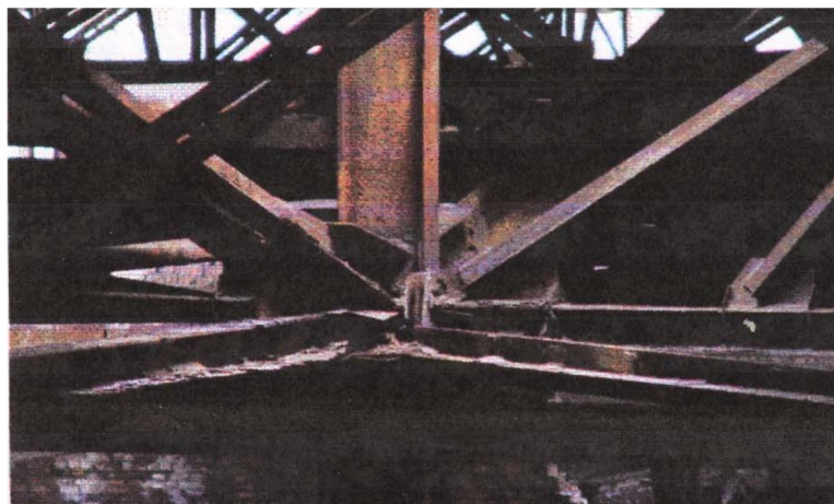
Рис. 3.2 - Виріз куточка в розкосі ферми
