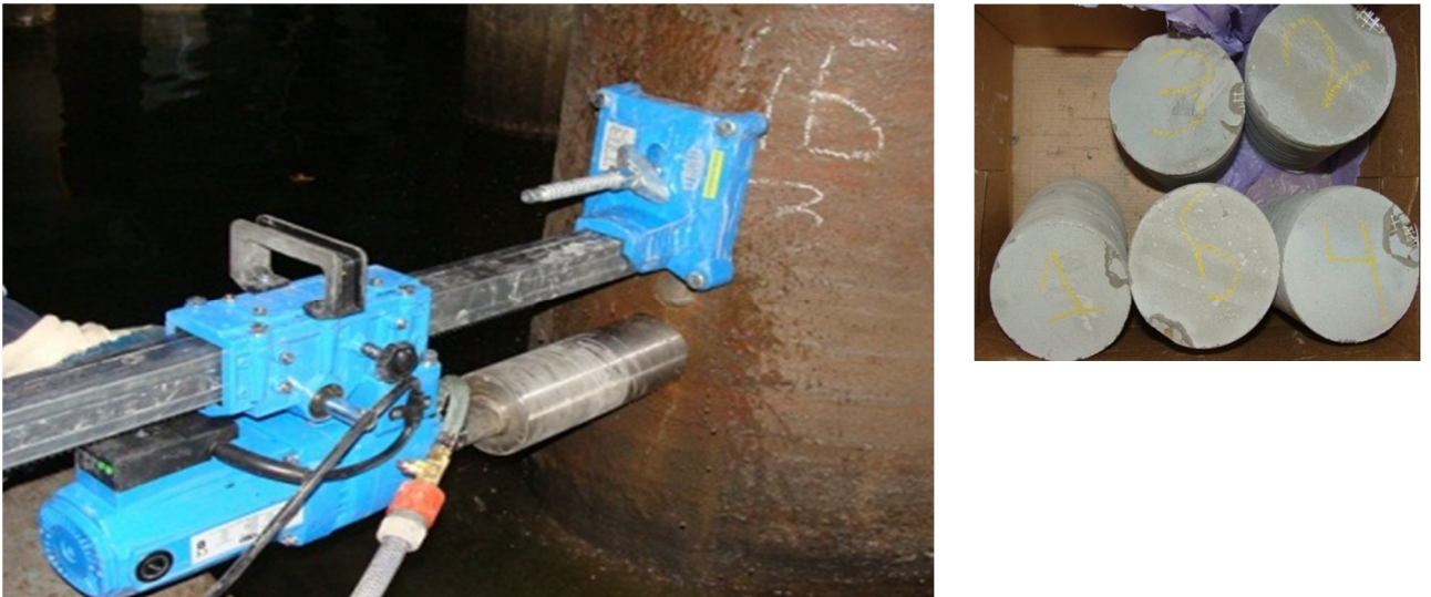
Рис. 3.9 - Зразки, вибурені з існуючих конструкцій системами алмазного буріння
