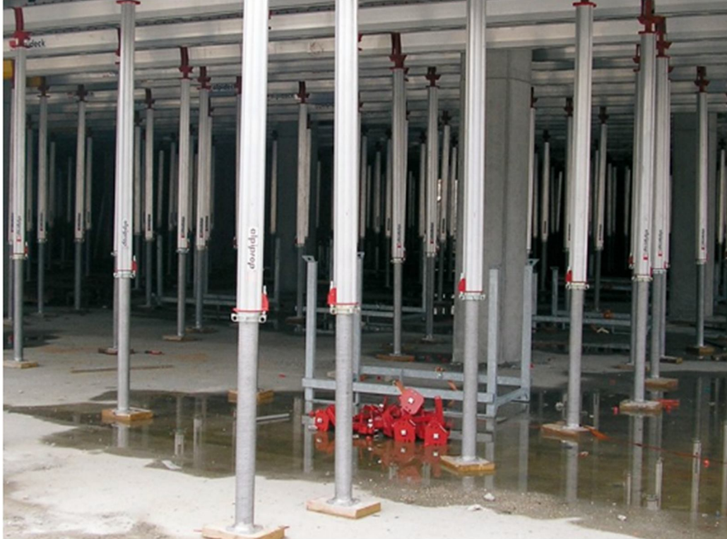
Рис. 4.7 - Зосереджені навантаження - телескопічні стійки-домкрати
