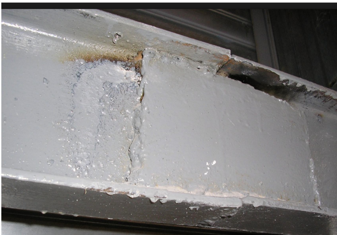
Рис. 3.7 - Відбір зразків у металевих конструкціях
