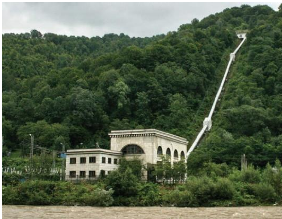
Рисунок 1.12 –Теребля-Рикська ГЕС (за приміщенням ГЕС видно «вихідний портал» тунелю й металевий водовід завдовжки 350 м)
