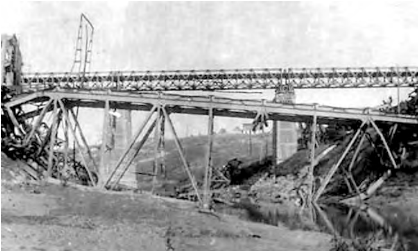
Зруйнований міст через р. Московка
