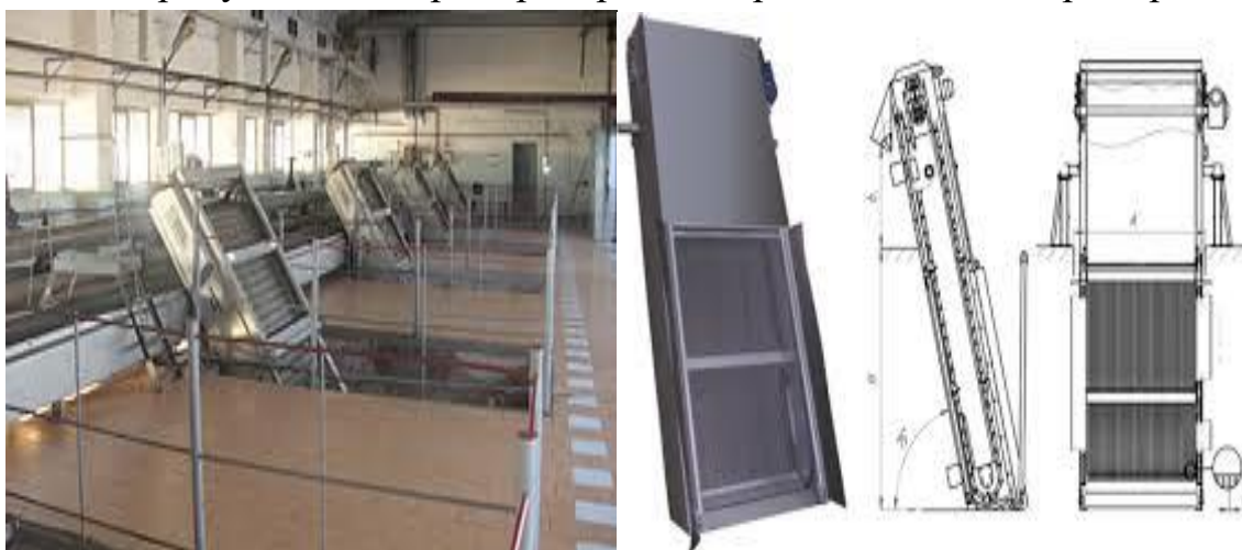
Рисунок 2.5 Грати механічної очистки
