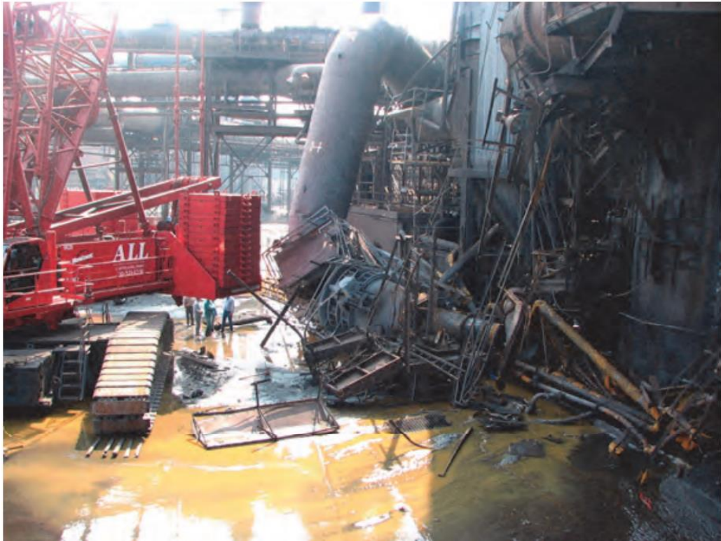
Рисунок 5.5 – Аварія на видувці доменної печі D, Burns Harbor (США) в 2008 г [13]
