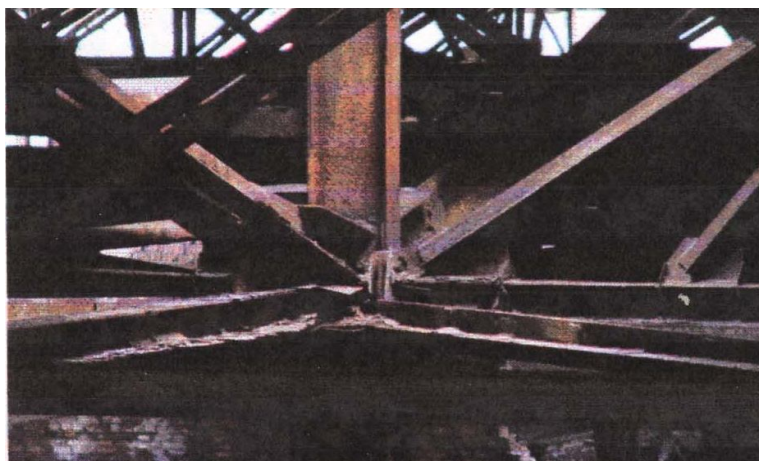
Рис. 3.2 - Виріз куточка в розкосі ферми
