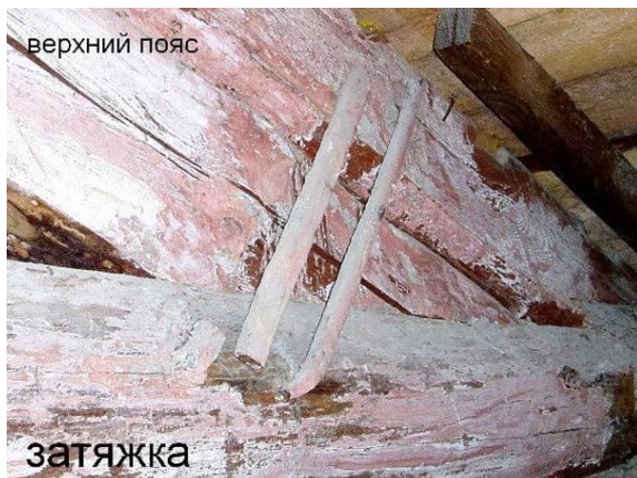
Рис. 3.4 - Дефекти дерев'яних конструкцій
