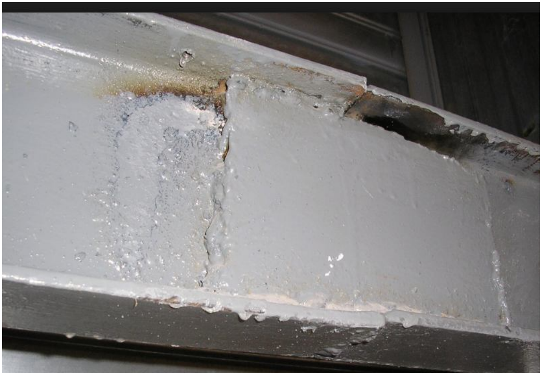
Рис. 3.7 - Відбір зразків у металевих конструкціях
