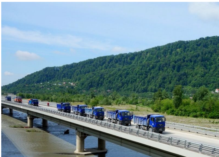
Рис. 4.4 - Випробування мостів динамічними навантаженнями
