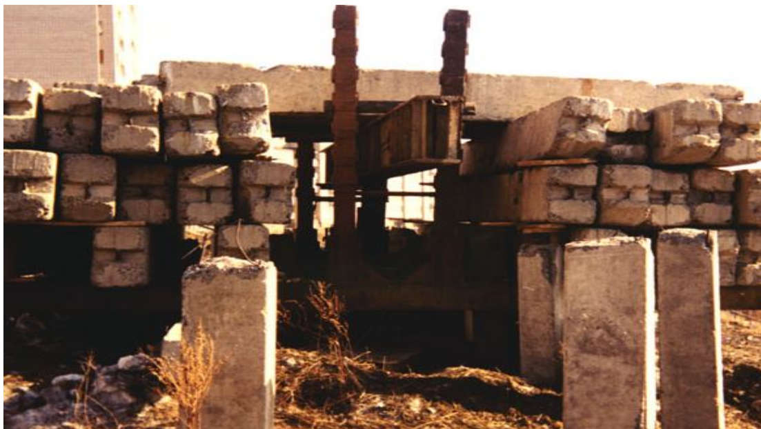
Рис. 4.1 - Випробування бурових палів статичними навантаженнями на ділянці будівництва
