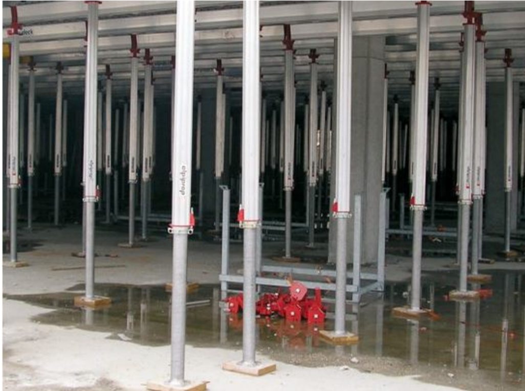
Рис. 4.7 - Зосереджені навантаження - телескопічні стійки-домкрати
