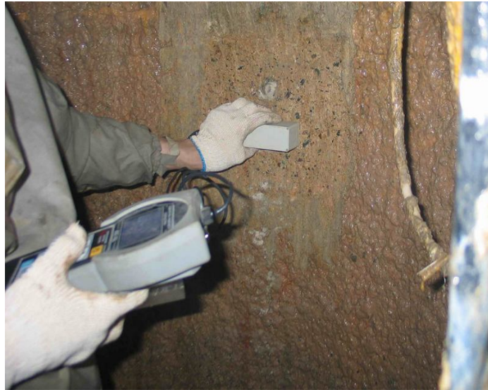
Рис. 3.29 - Визначення захисного шару бетону приладом ІЗС-10Ц
