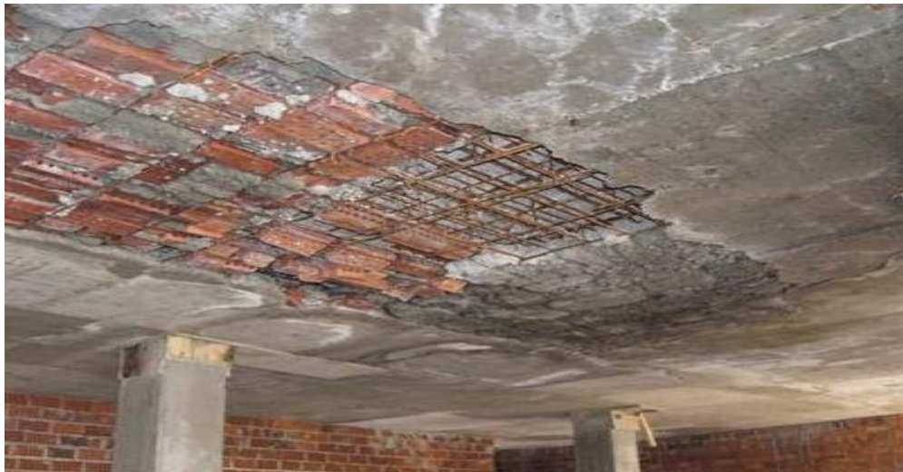
Рис. 3.6 - Дефекти ділянок кладки
