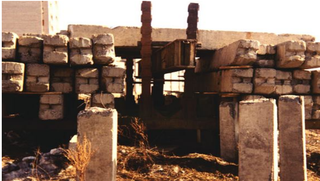
Рис. 4.1 - Випробування бурових палей статичними навантаженнями на ділянці будівництва
