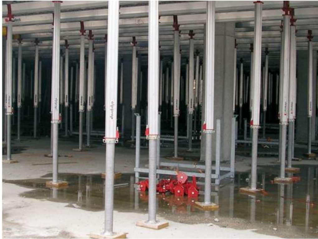
Рис. 4.7 - Зосереджені навантаження - телескопічні стійки-домкрати
