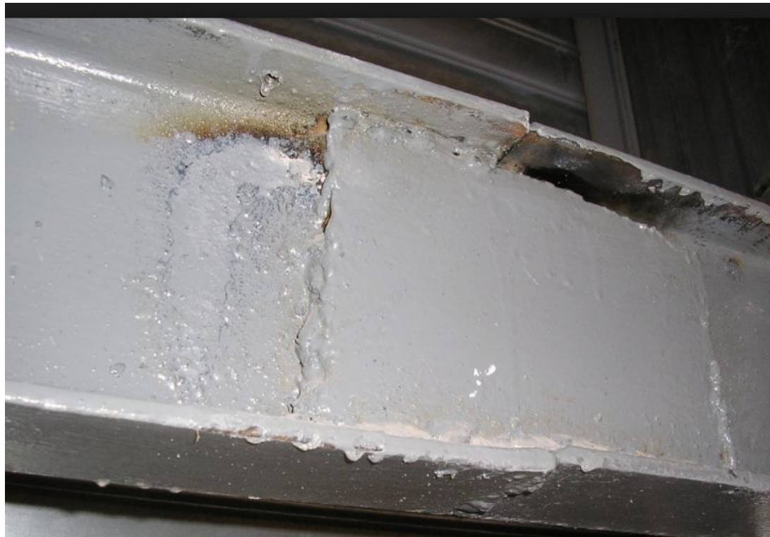
Рис. 3.7 - Відбір зразків у металевих конструкціях
