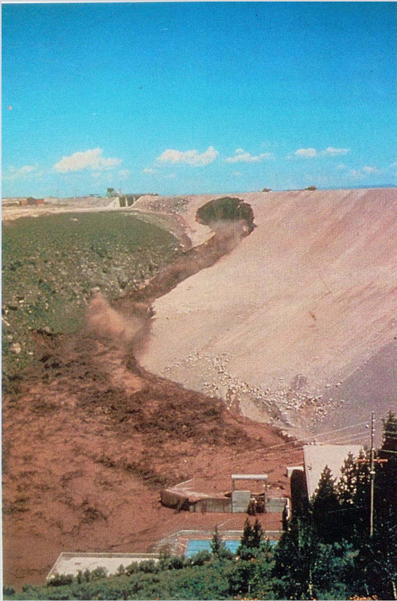
Руйнування греблі Тетон (США) в 1976 р. Висота 93 м. Загинуло 11 осіб. Збитки більше 1 млрд. доларів США
