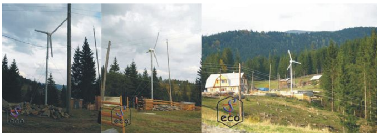
Рис. 4.4. Вітроелектростанція потужністю 10 кВт (с. Поляниця)
