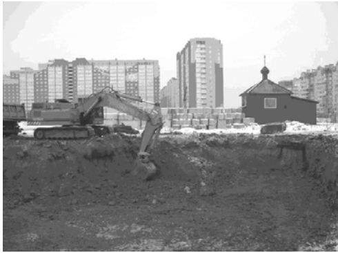
Рис. 4.2. Виймка ґрунту під котлован
