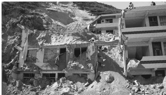
Рис. 4.5. Зсув ґрунту
