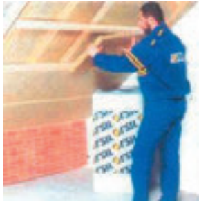
Рис. 2.4.3. Утеплення приміщення на горищі
