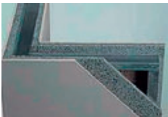
Рис. 2.4.8. Внутрішнє утеплення стін
