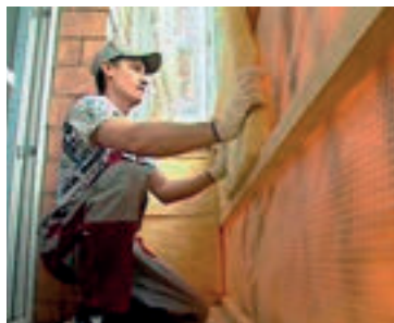
Рис. 2.4.14. Утеплення фасаду мінераловатними плитами
