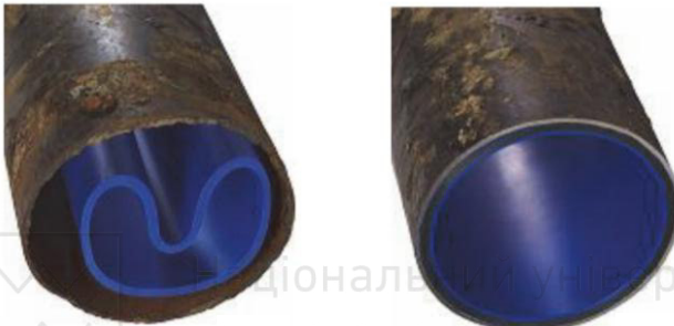
Рис. 3.19. Санация трубопровода попередньо складеним покриттям: а) під час ремонту; б) після ремонту
