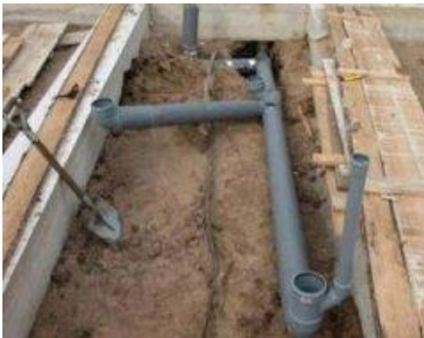
Система внутрішнього водовідведення
