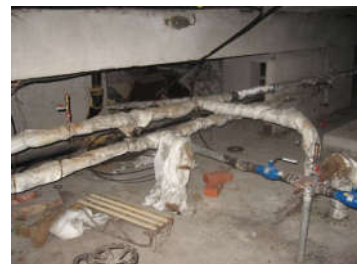
Застарілі інженерні мережі/трубопроводи/ незбалансовані системи опалення
