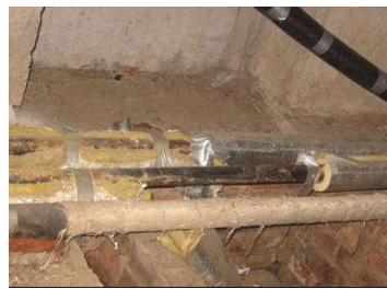
Застарілі інженерні мережі/трубопроводи/ незбалансовані системи опалення
