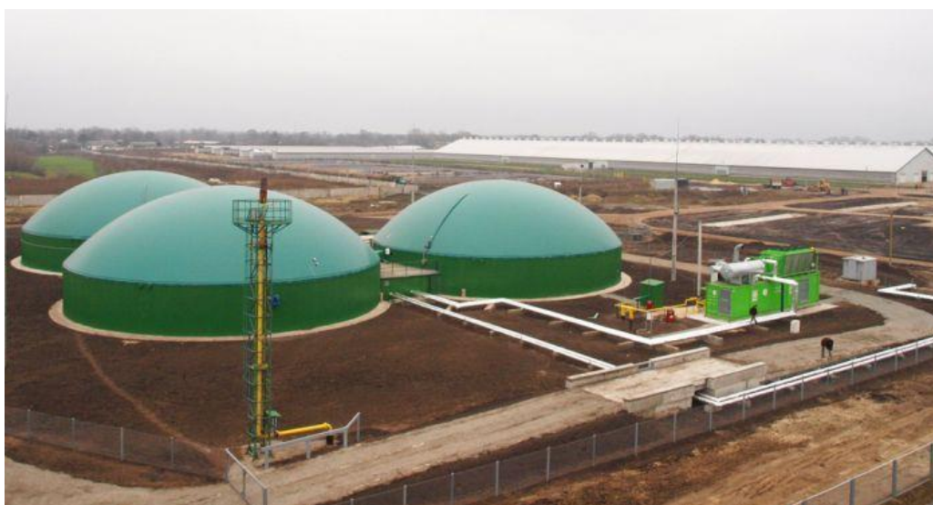
Рисунок 4.4 – Метантенки біогазової установки
