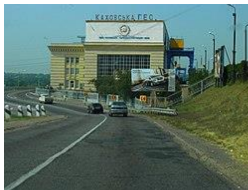
Рис. Шляхопровід через Каховську ГЕС
