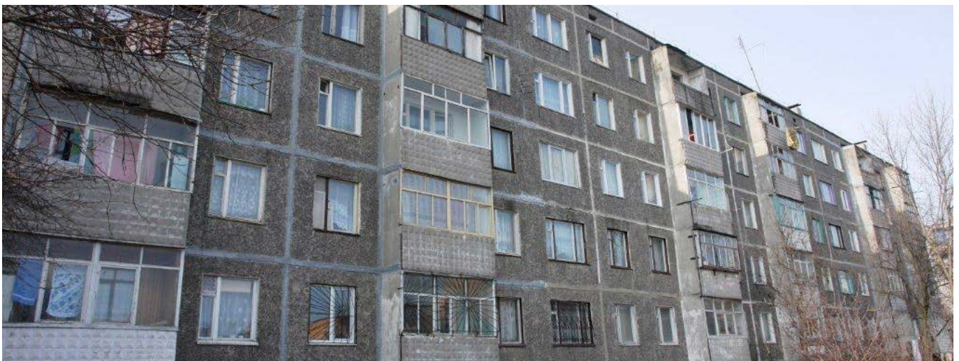
Мал. 19. Загальний вигляд будинку до термосанації
