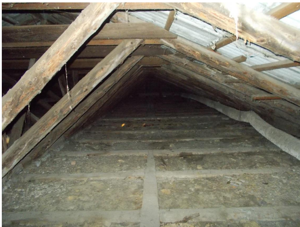
Рисунок 3 – Стан горищного приміщення
