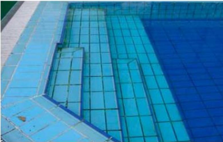
1. Басейн до застосування діоксиду хлору Dutrion. Дуже запущений, видно утворення біоплівки, обростання водоростями та різні мінеральні відкладення на стінках і швах плитки
