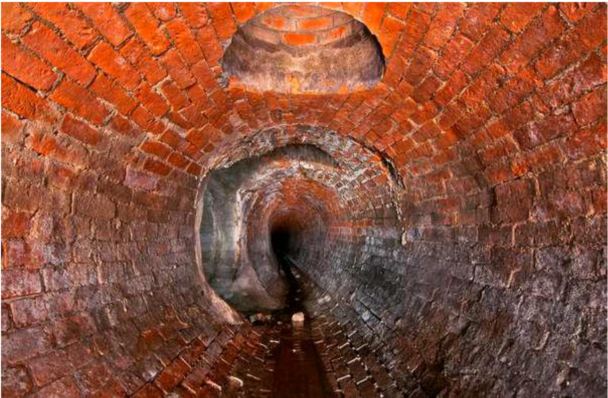
Рис. 1.9. Цегляний колектор
