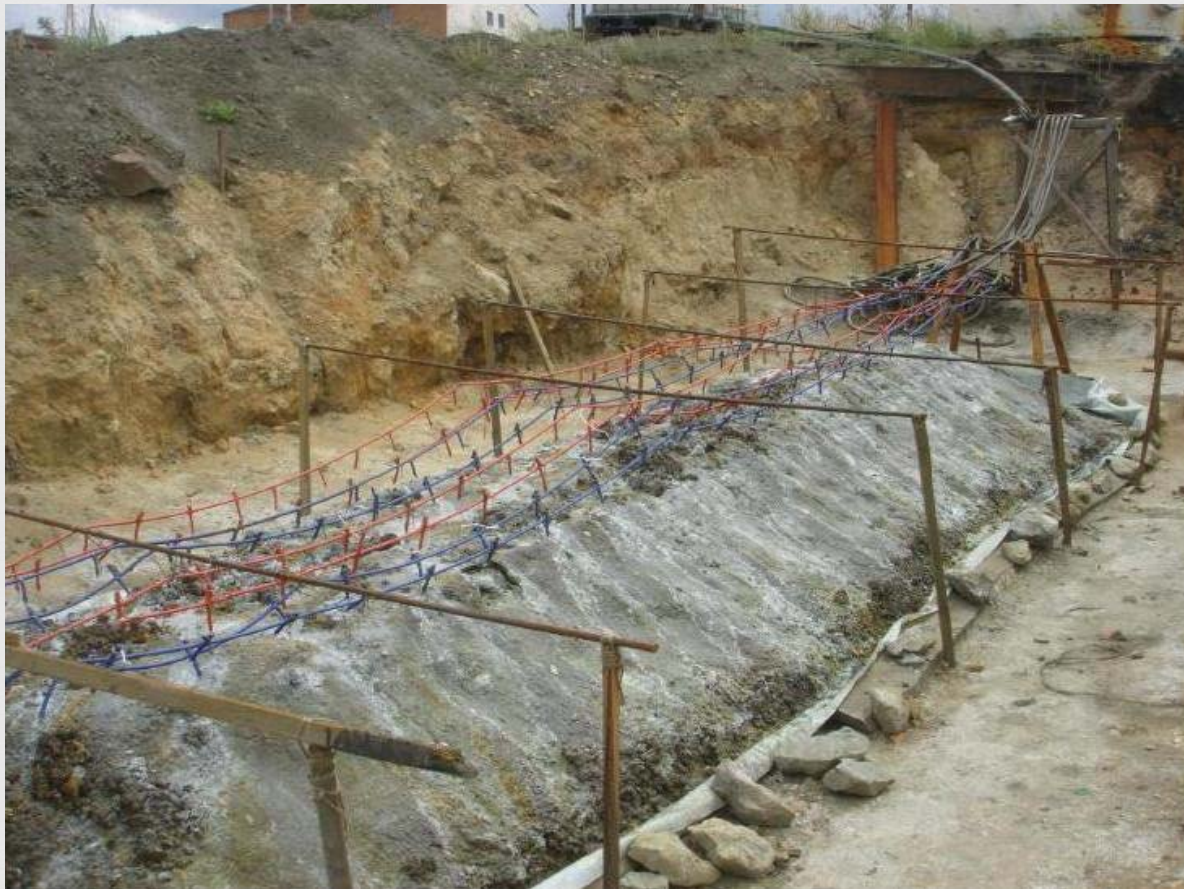
Внешний вид штабеля кучного выщелачивания
