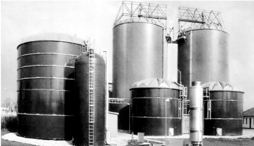
Рис. 22.9. Біогазова установка в містечку Нойбуков (Німеччина) розробки фірми «Фарматік Біотех Енергі АГ» (за Ясенецьким В., Клименко В., 2001)
