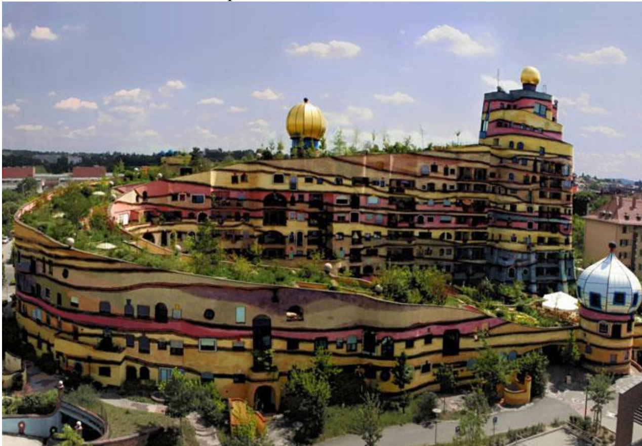
Рисунок 12 – Загальний вигляд житлового комплексу «Лісова спіраль»
