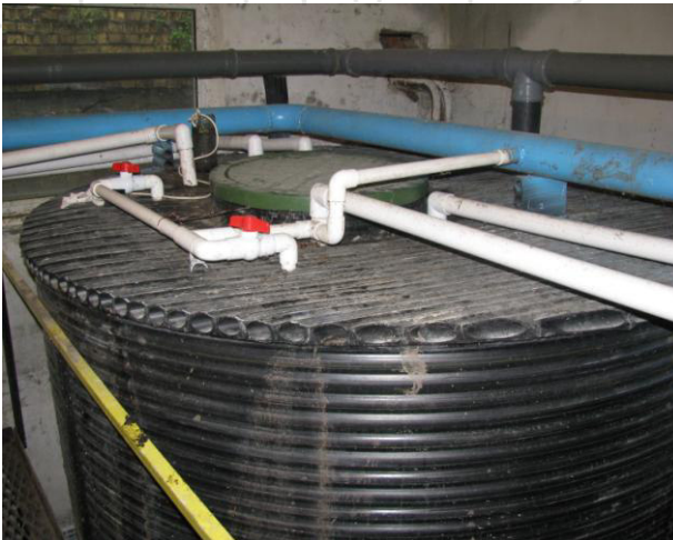
Рис. 1. Фото очисної станції з біореакторами з іммобілізованими мікроорганізмами (зверху) і окремого біореактора (знизу)
