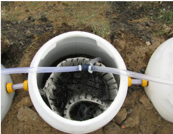
Рис. 2. Фото аеробного біореактора під час монтажу (зверху) і аноксидного при гідравлічному випробуванні (знизу)
