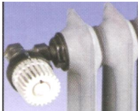
Рис. 4.24. Встановлення терморегулятора на радіатор
