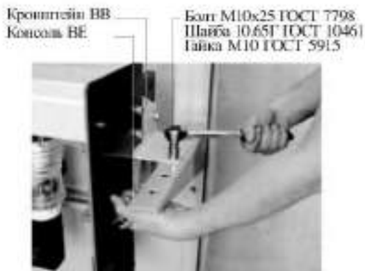
Рисунок 8.12 – Установка вакуумного вимикача на консоль
