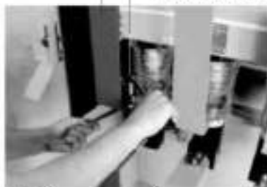
Рисунок 8.14 – Криплення верхніх шин головних струмових кіл
