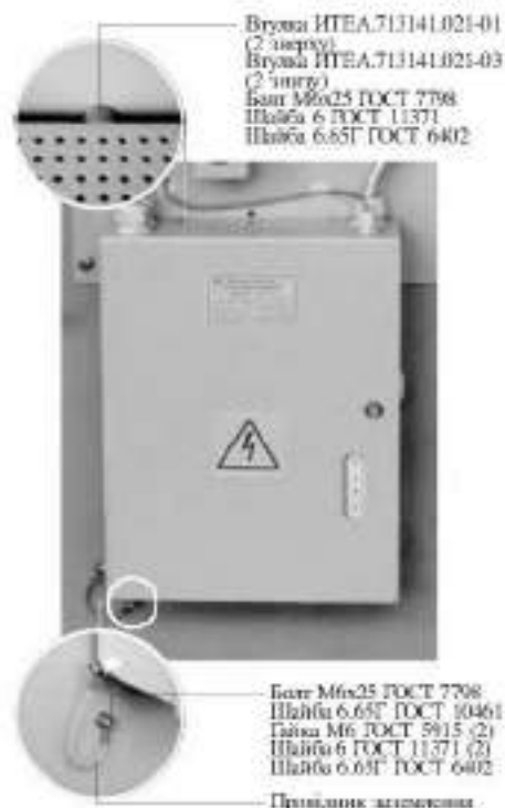
Рисунок 8.20 – Установка і заземлення ШВС на фасаді ВЕ
