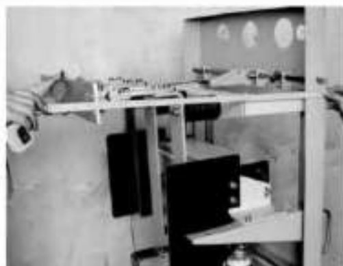
Рисунок 8.19 – Налаштування положення по глибині верхніх ШРК фаз L1, L3
