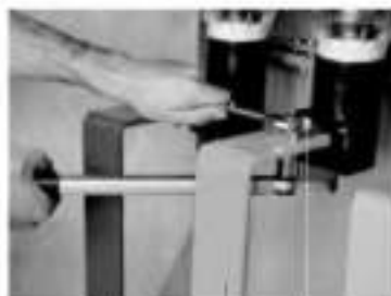
Шина познач ВВ Болт М10х40 ГОСТ 7798 Шайба 10 ГОСТ 11371 Шайба 10.65 ГОСТ 6402 Гайка 10 ГОСТ 5915
