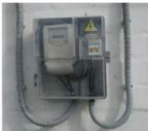
Рисунок 2.22 – Встановлення лічильника електричної енергії на ввіді в будинок
