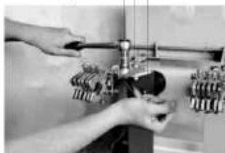
Рисунок 8.16 – Монтаж верхніх ШРК на шинах ВВ
