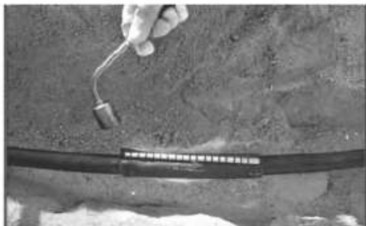
Рисунок 7.3 – Ескіз термоусаджувального манжета HDCW
