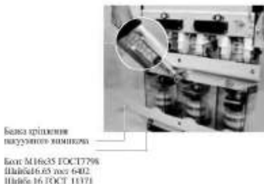
Рисунок 8.11 – Встановлення балок для кріплення вакуумного вимикача
