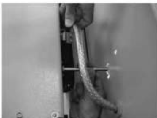
Рисунок 8.21 – Фіксація тяги в блокувальній тязі ВВ
