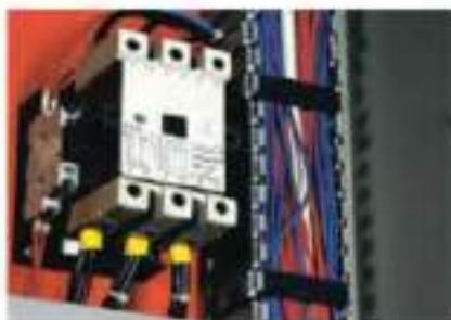
Рисуюнок 2.13 – Кабеленесуча система та комутаційні елементи "QUADRO"
