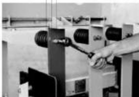
Рисунок 8.15 – Кріплення верхніх шин на опорних ізоляторах
