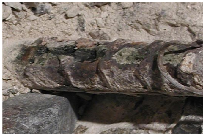
Корозія арматури в місці руйнування захисного шару
