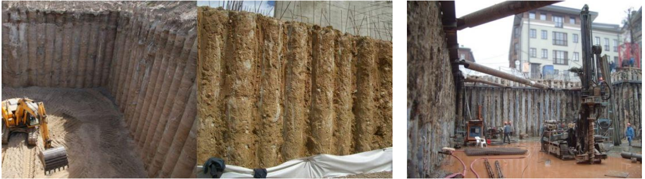
Рисунок 3.12 – Конструкція фундаменту зведена способом «стіна в ґрунті»:
