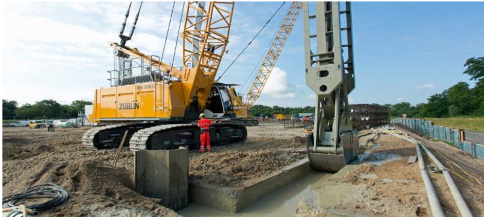
Рисунок 3.18 - Технологічна схема розробки траншеї методом «стіна в ґрунті».
