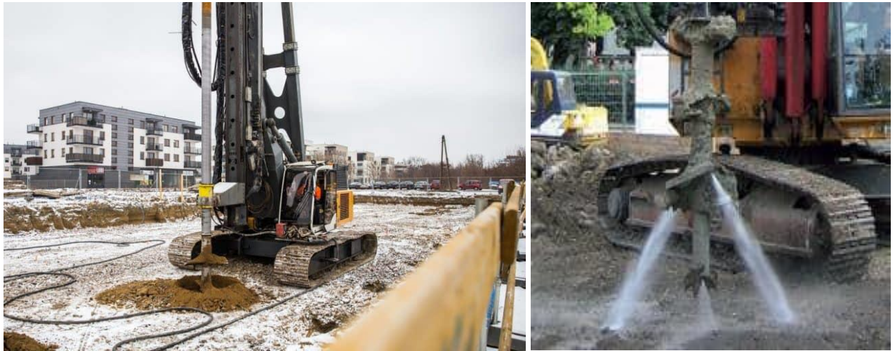
Рисунок 3.23 - Установка для влаштування паль типу DSM
