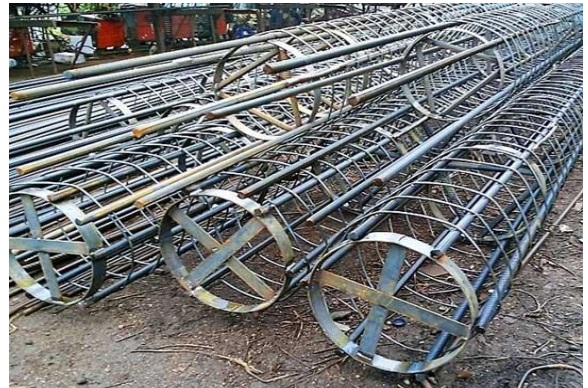
Рисунок 3.10 - Арматурні каркаси для глибоких бурових опор: а - з фіксувальними коротунами; б-зі спрямовуючими кутиками; 1 - стрижні поздовжньої арматури
