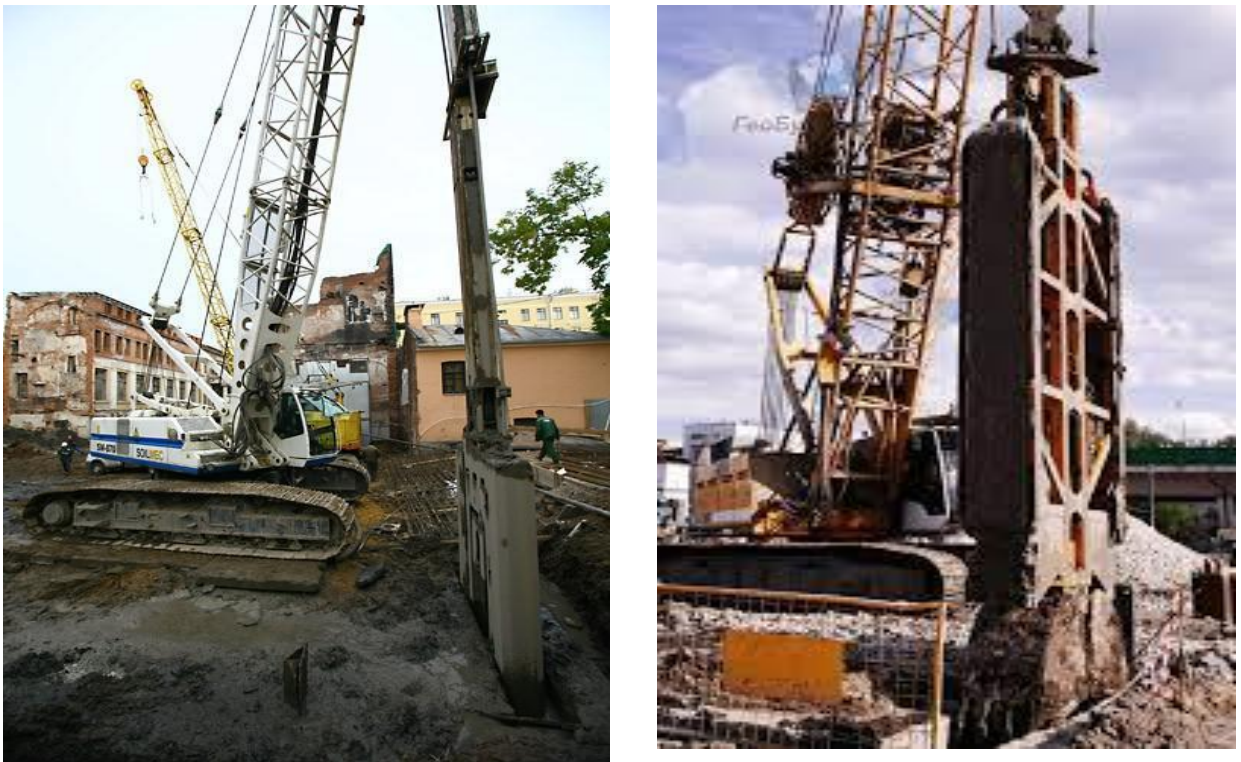
Рисунок 3.24 – Двохщелепний напірний грейфер
