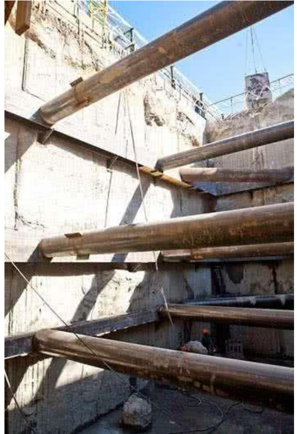
Рисунок 3.19 – Укріплення стінок котловану зведених по методу «стіна в ґрунті»
