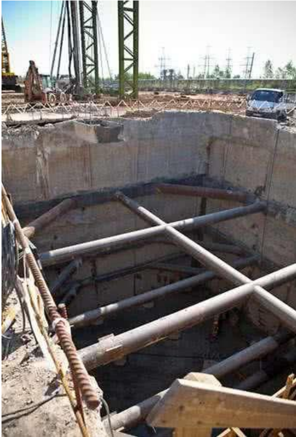
Рисунок 3.19 – Укріплення стінок котловану зведених по методу «стіна в ґрунті»
