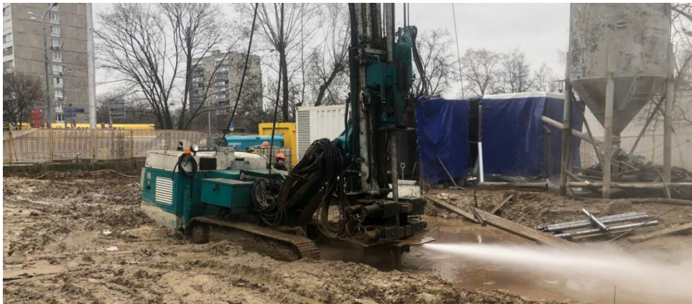
Рисунок 3.21 - Підготовка установки для цементації ґрунту
