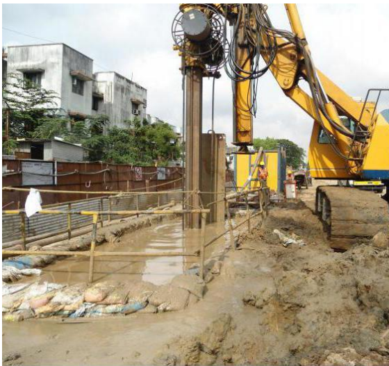
Рисунок 3.26 – Влаштування траншеї та монтаж арматурного каркасу
