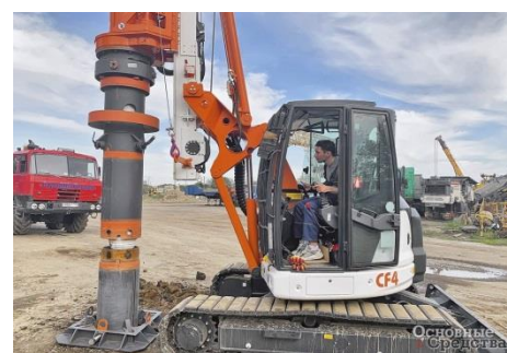
Рисунок 3.5 – Бурова установка Soilmec S.p.A та обладнання з полегшеними двохстінними обсадними трубами \varnothing 610 мм виробництва PTC ERDE TOOLS на обладнанні TesCar CF4
