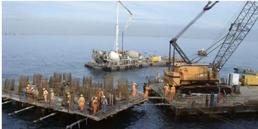
Рисунок 3.9 - Влаштування глибокої бурової опори у водоймі
