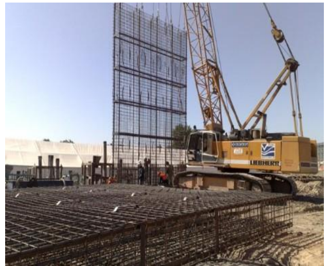
Рисунок 3.26 – Влаштування траншеї та монтаж арматурного каркасу
