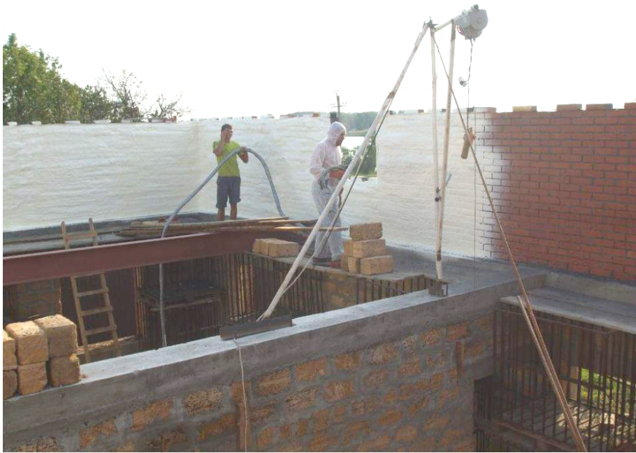
Рис. 6.10. Утеплення конструкцій напленням пінополіуретану.
