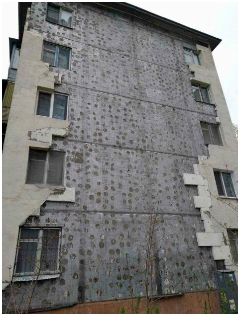
Рис. 6.1. Обрушення фасадних систем під час експлуатації будівель.
