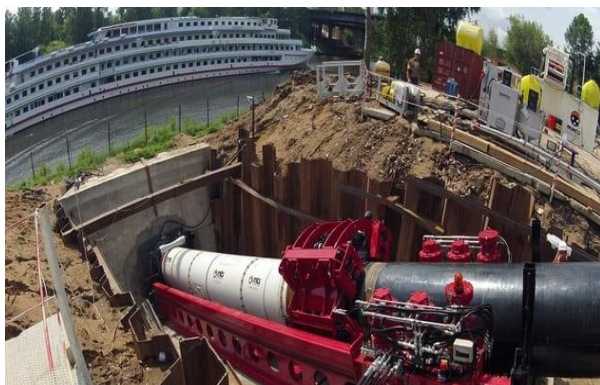
Рисунок 5.3 - Схема влаштування закритої проходки продавлюванням
