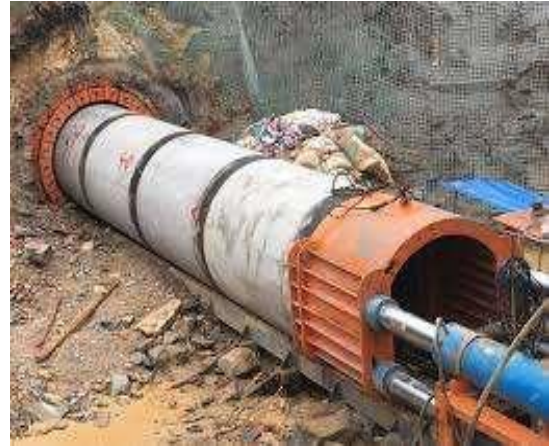
Рисунок 5.7 - Прокладання комунікацій вдавлюванням залізобетонних труб
