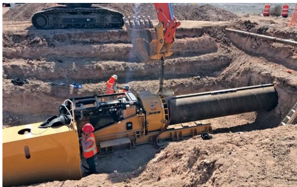
Рисунок 5.6 - Загальний вигляд установки для горизонтального буріння.
