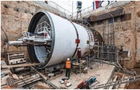
Рисунок 5.9 - Влаштування споруди тунелю тунелепрохідницьким комплексом
