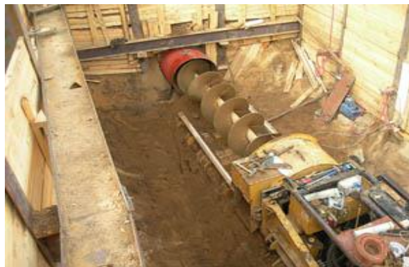
Рисунок 5.6 - Загальний вигляд установки для горизонтального буріння.
