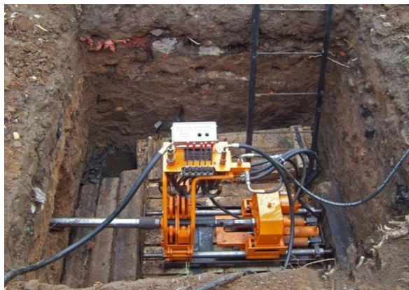
Рисунок 5.2 - Установка для прокладання комунікацій методом проколу
