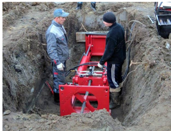
Рисунок 5.2 - Установка для прокладання комунікацій методом проколу
