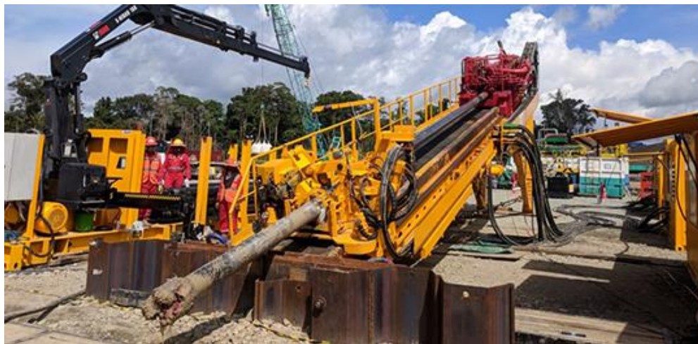
Рисунок 5.12 – Прокладання комунікацій проводиться спеціальними установками горизонтально-спрямованого буріння (ГСБ)
