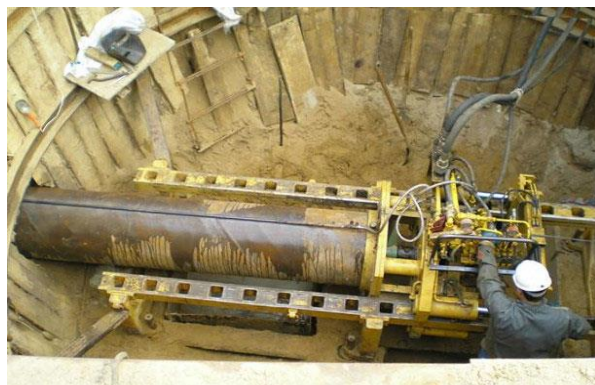
Рисунок 5.3 - Схема влаштування закритої проходки продавлюванням
