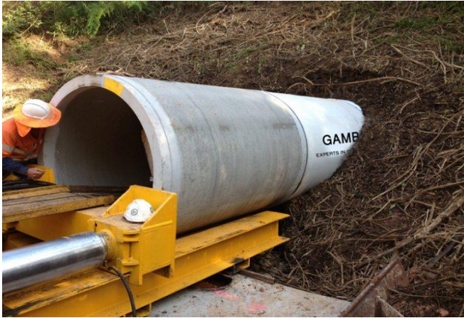
Рисунок 5.7 - Прокладання комунікацій вдавлюванням залізобетонних труб
