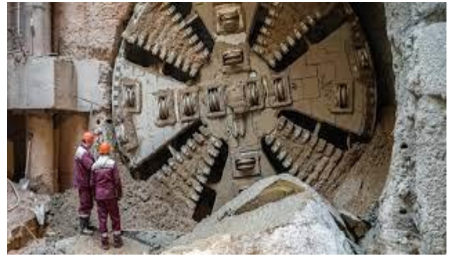
Рисунок 5.9 - Влаштування споруди тунелю тунелепрохідницьким комплексом
