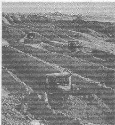
Будівництво зрошувального каналу
