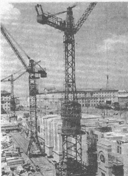
Спорудження житлових будинків у Запоріжжі, 1956 р.
