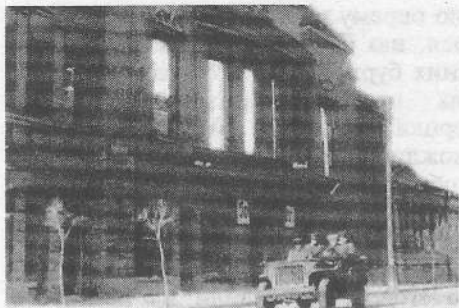
Будівля Запорізького драматичного театру. Жовтень 1943 р.
