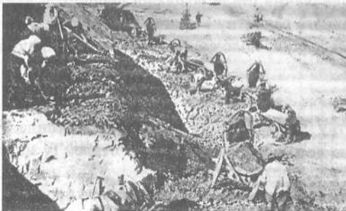
Початок будівельних робіт на металургійному комбінаті
