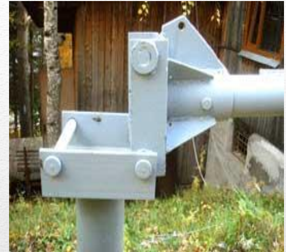
Шарнірне з'єднання споруди з фундаментом
