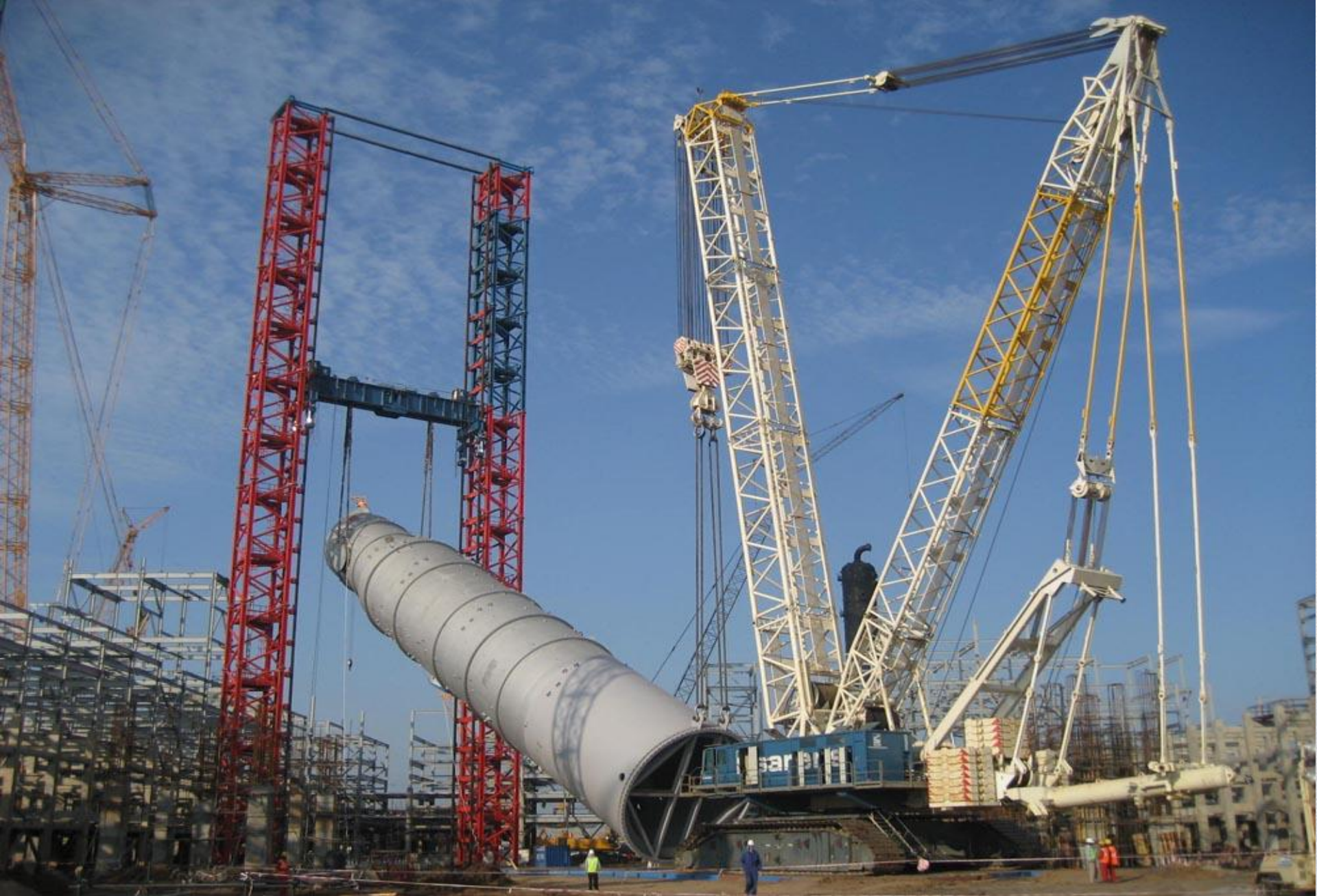
Монтаж секції труби монтажною щоглою та допоміжним краном Demag CC 8800
