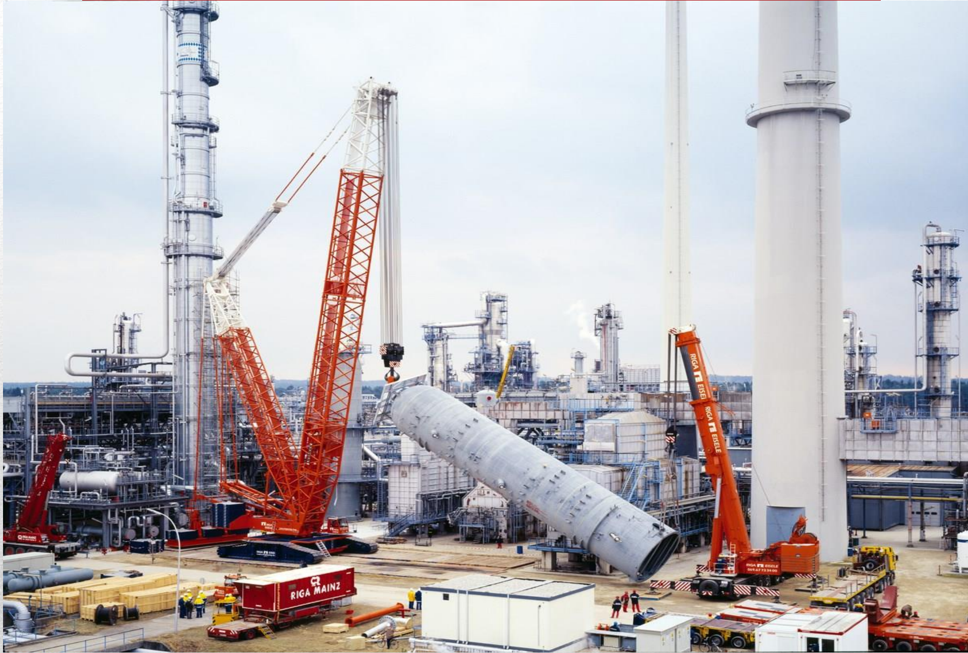
Монтаж секції труби телескопічним мобільним краном LTM 1350-6.1
