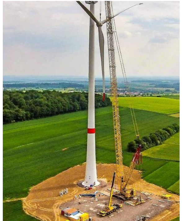
Рисунок 6.8. - Зведення баштових споруд вітрогенераторів
