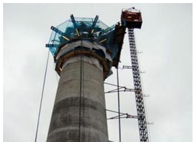
Рисунок 6.22 - Зведення висотної споруди за допомогою ковзної опалубки
