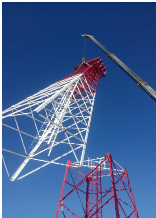
Рисунок 6.6 - Зведення башти укрупненими блоками.
