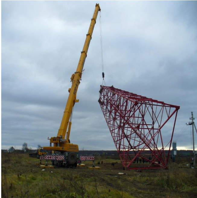
Рісунок 6.7 - Зведення баштових споруд укрупненими елементами : а - одним краном; б - двома кранами
