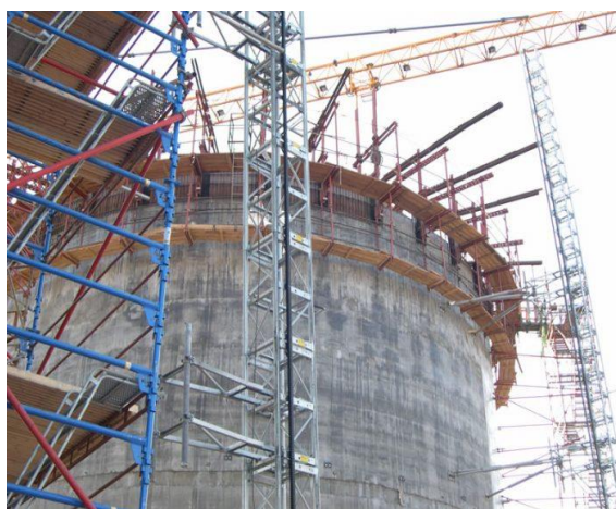
Рисунок 6.22 - Зведення висотної споруди за допомогою ковзної опалубки
