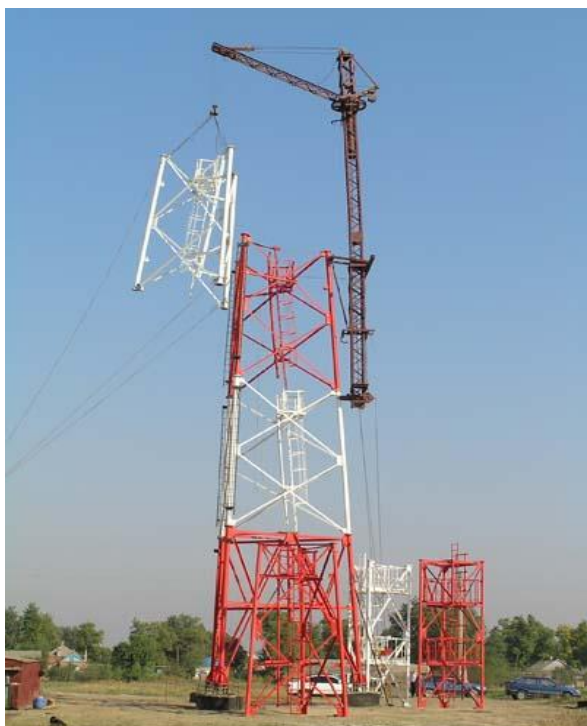
Рисунок 6.12 – Монтаж баштових споруд самопідіймальними (повзучими) кранами
