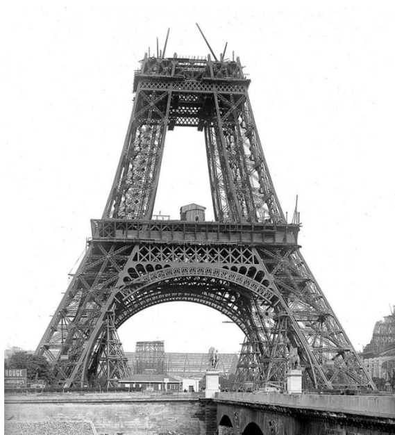
Рисунок 6.3 – Технологічна послідовність зведення Ейфелевої вежі методом наросування
