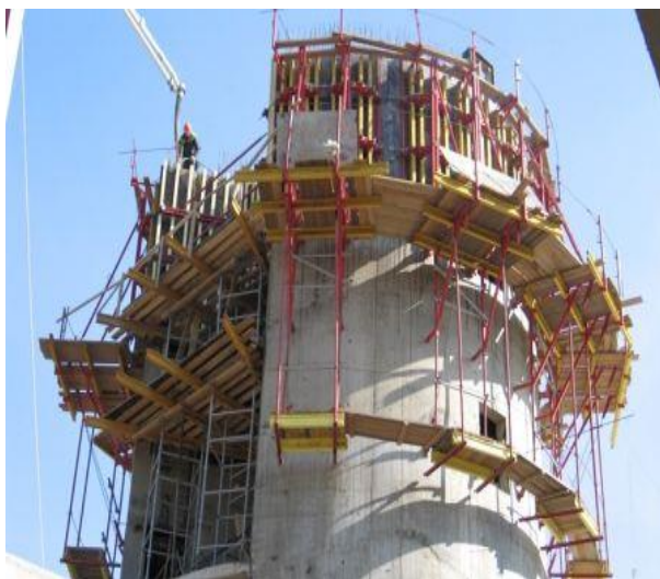
Рисунок 6.21 - Зведення баштової споруди за допомогою підйомно-переставної опалубки: - бетонована стіна; - зовнішні опалубні щити; - внутрішні опалубні щити; - підймальний пристрій; 5, 6 - шахта опорно-підйомного пристрою; підвіски; 7 - робочий майданчик; 8 - опорні балки; 9, 10 - зовнішні і внутрішні підвісні помости
