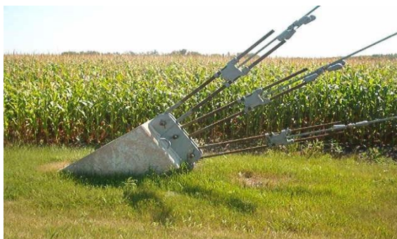
Рисунок 6.4 - Вигляд якоря щогли
