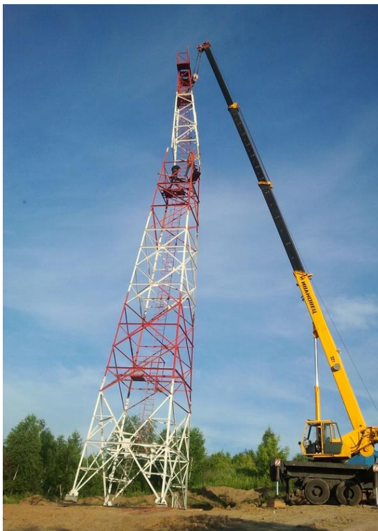
Рисунок 6.6 - Зведення башти укрупненими блоками.
