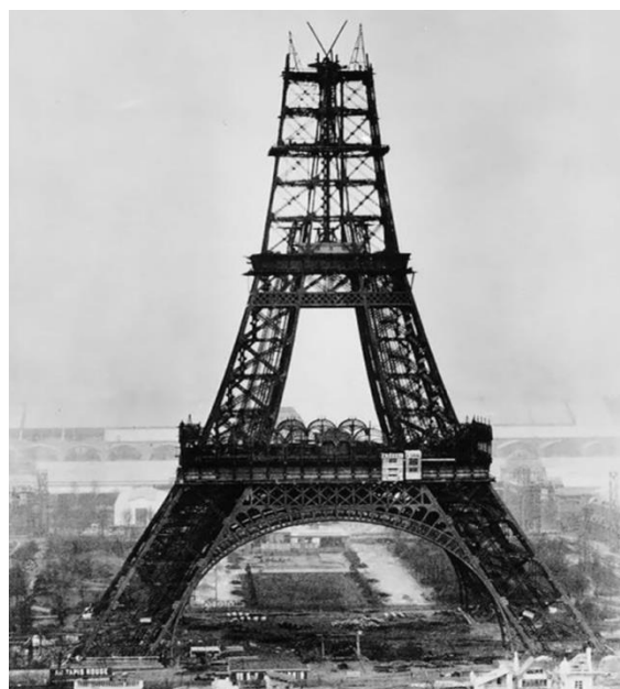
Рисунок 6.3 – Технологічна послідовність зведення Ейфелевої вежі методом наросування
