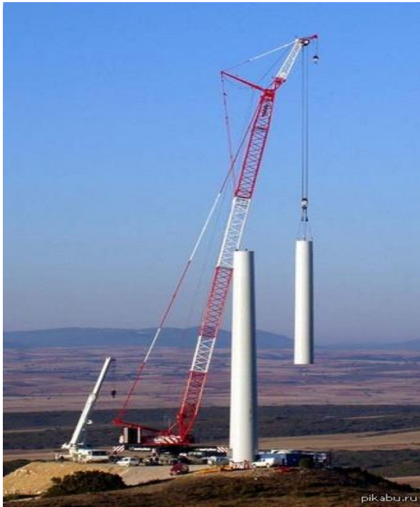
Рисунок 6.8. - Зведення баштових споруд вітрогенераторів
