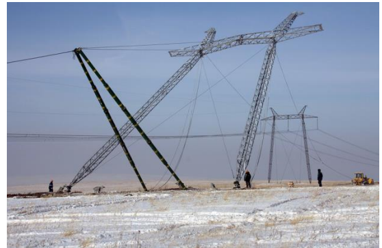
Рисунок 6.16 – Монтаж баштових споруд методом повороту.
