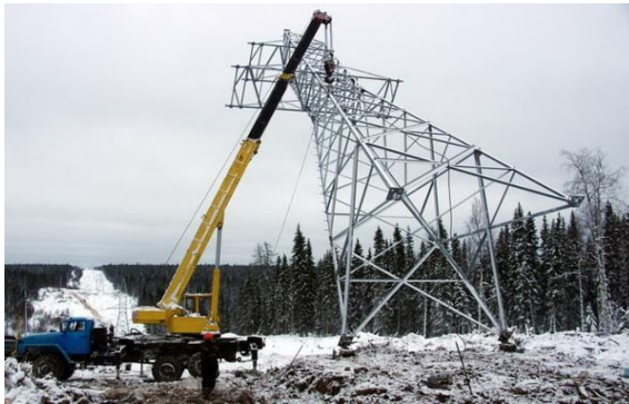
Рисунок 6.16 – Монтаж баштових споруд методом повороту.
