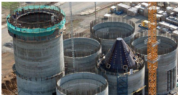
Рисунок 10 - Загальний вигляд силосної споруди із монолітного залізобетону
