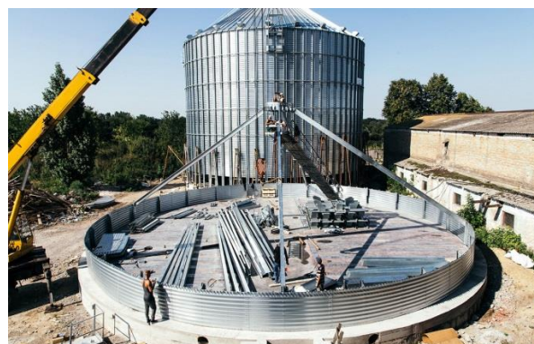
Рисунок 4 – Влаштування конструкції фундаменту та покриття силосної споруди
