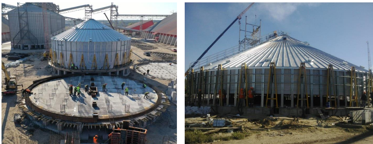
Рисунок 5 – Процес зведення силосної споруди методом підрощування – монтаж технологічного обладнання (рис. 6).
