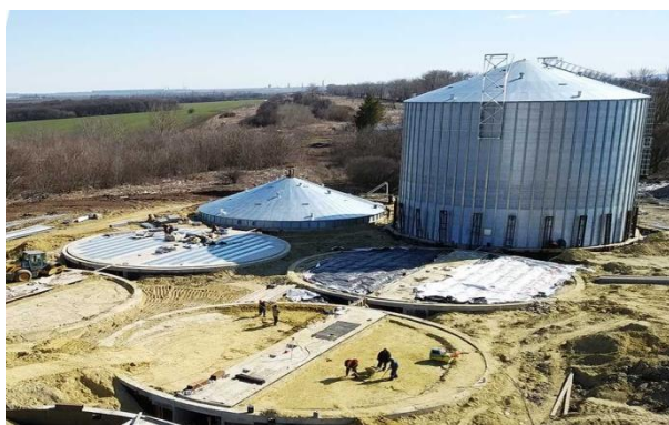
Рисунок 4 – Влаштування конструкції фундаменту та покриття силосної споруди
