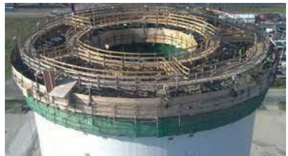
Рисунок 10 - Загальний вигляд силосної споруди із монолітного залізобетону
