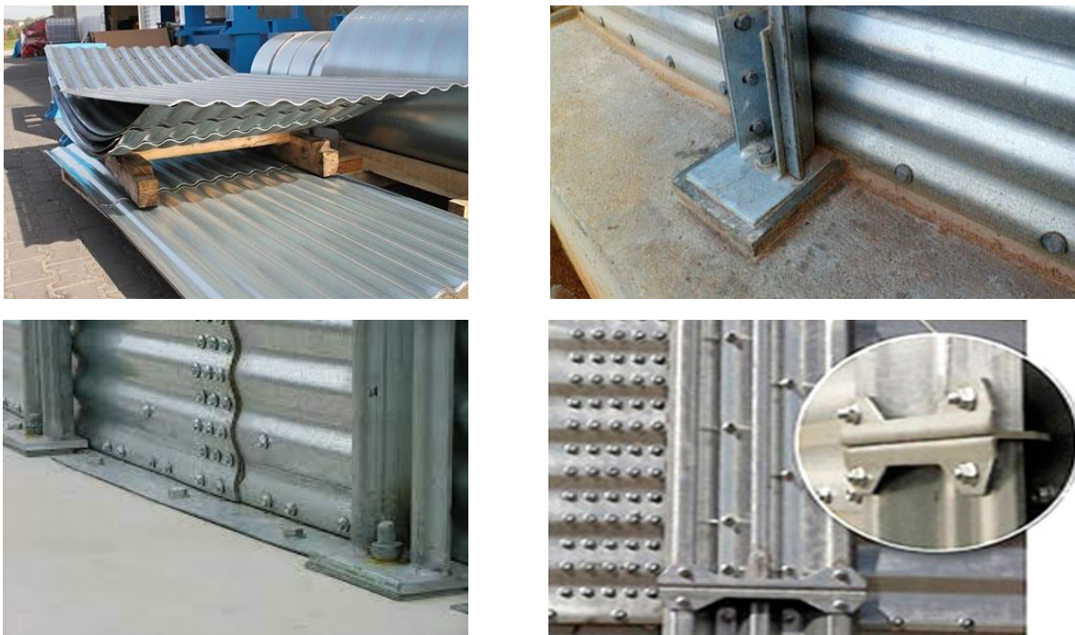
Рисунок 6 – Конструкція елементів силосу зі сталевих елементів
