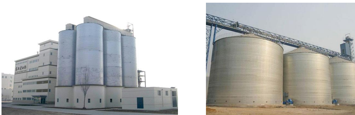
Рисунок 8 - Загальний вигляд силосних споруд виконаних за допомогою технологією спірального намотування
