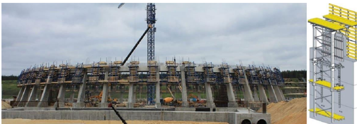
Рисунок 6 - Зведення башти градирні за допомогою підйомно-переставної опалубки
