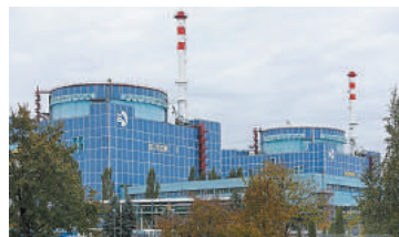
Рис. 42.9. Хмельницька АЕС: 2 атомні енергоблоки потужністю 1000 МВт кожен
