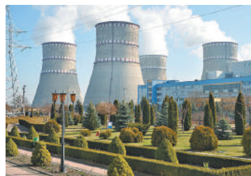
Рис. 42.7. Рівненська АЕС: 4 атомні енергоблоки загальною потужністю 2835 МВт
