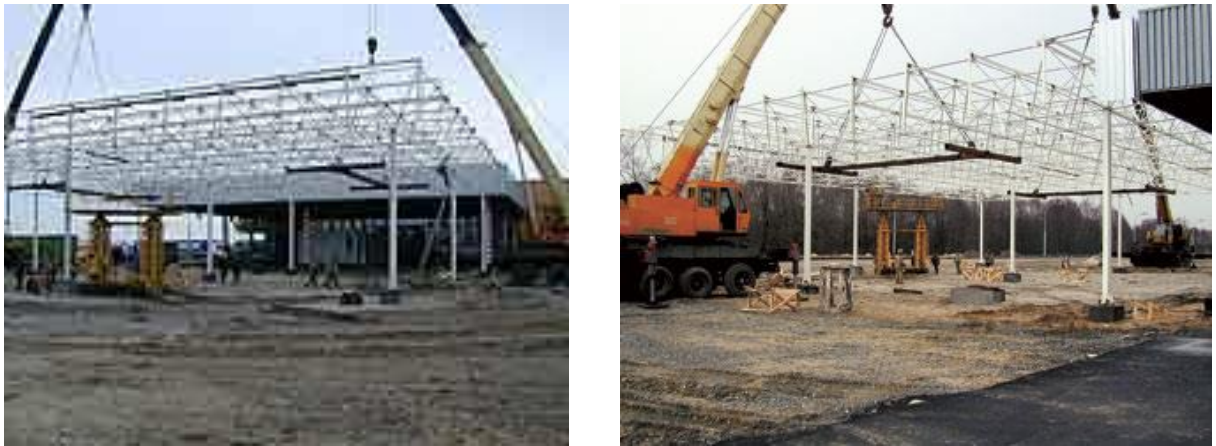
Рисунок 21 - Монтаж просторової структури методом підіймання на опори
