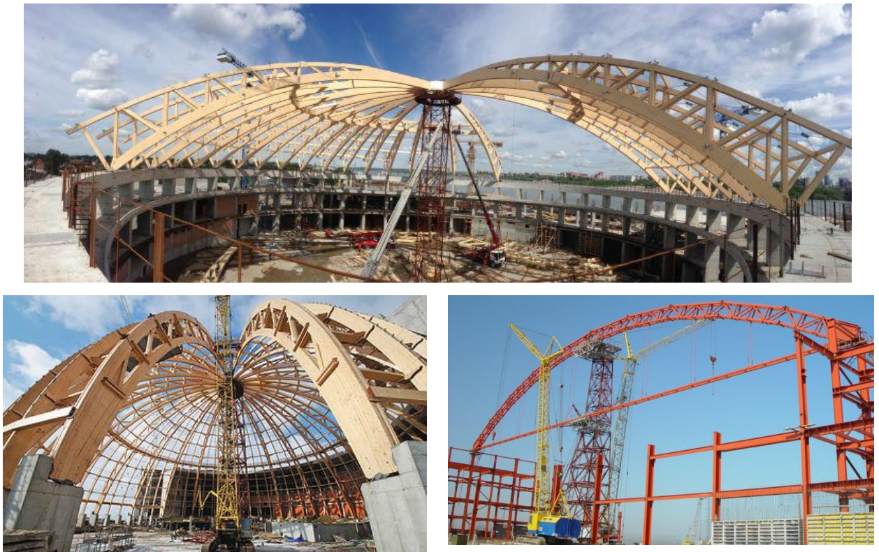
Рисунок 18 - Монтаж конструкцій покриття арочної споруди за допомогою тимчасової опори
