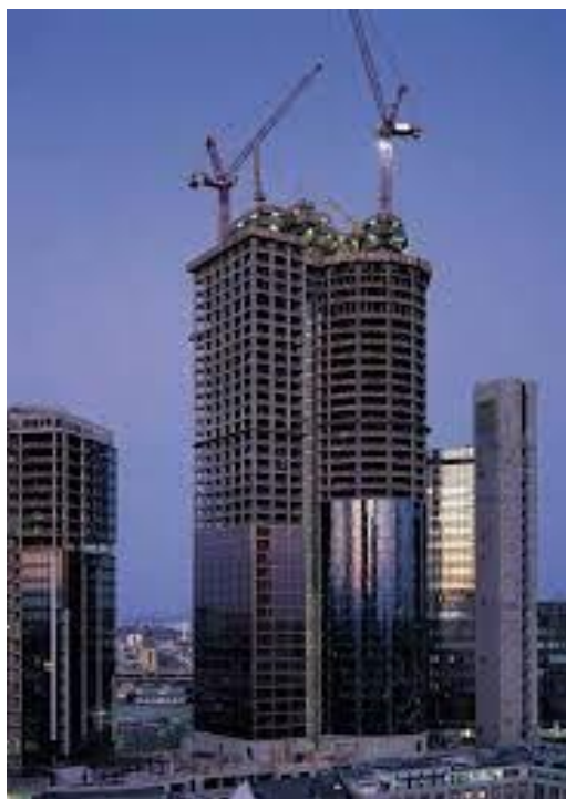
Рисунок 9 - Зведення хмарочосу Майнтауер у Франкфурті-на-Майні (Німеччина) за технологією «зверху-вниз»: а - процес зведення; б - завершений вигляд
