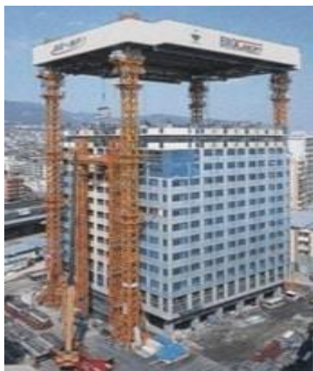
Рисунок 7 – Зведення висотної будівлі за допомогою автоматизованих будівельних комплексів, що спираються на додаткові підтримуючі конструкції
