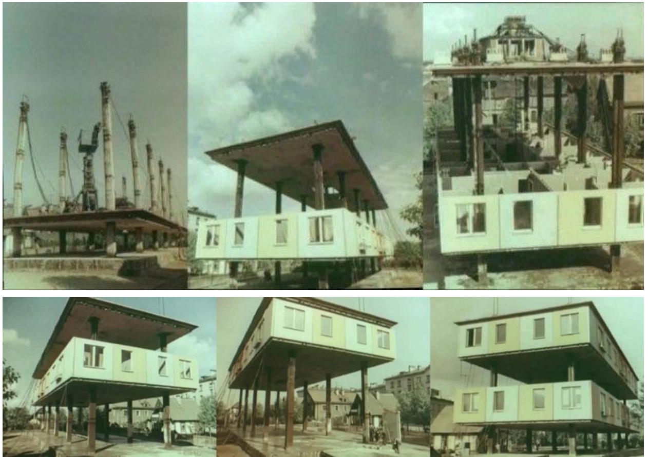
Рисунок 10 – Послідовність монтажу панельного будинку Методом «зверху-вниз»
