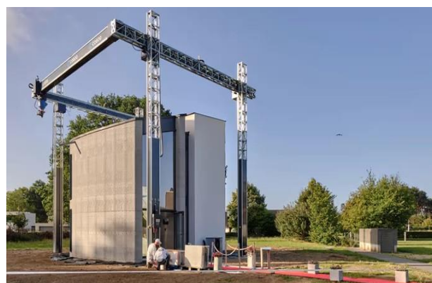
Рисунок 8 – Зведення будівлі за допомогою автоматизованого комплексу типу «Смарт» - система
