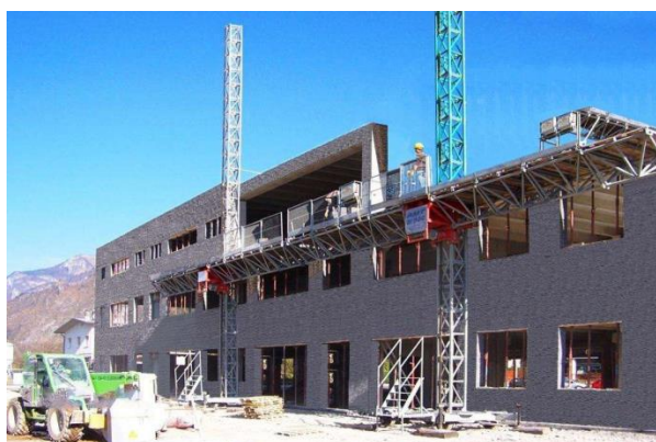
Рисунок 8 – Зведення будівлі за допомогою автоматизованого комплексу типу «Смарт» - система
