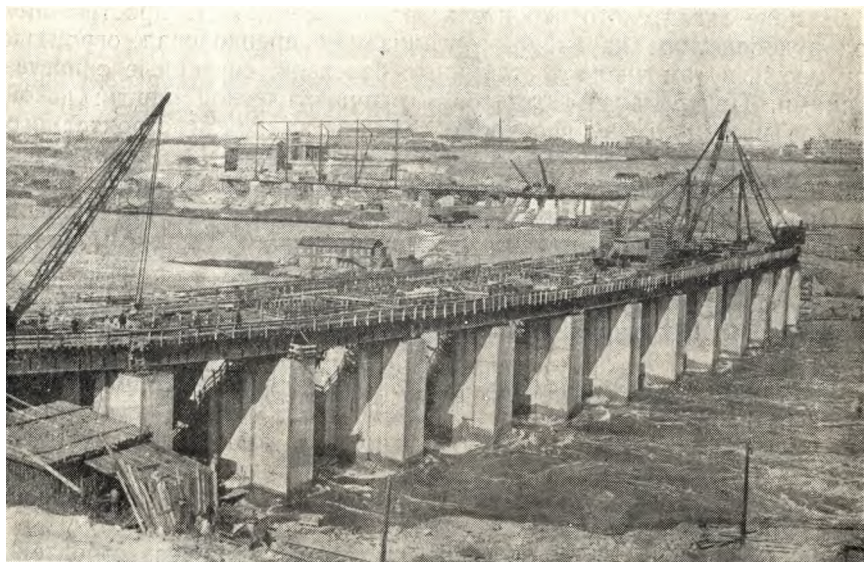
Общий вид строительства плотины Днепрогэса.
