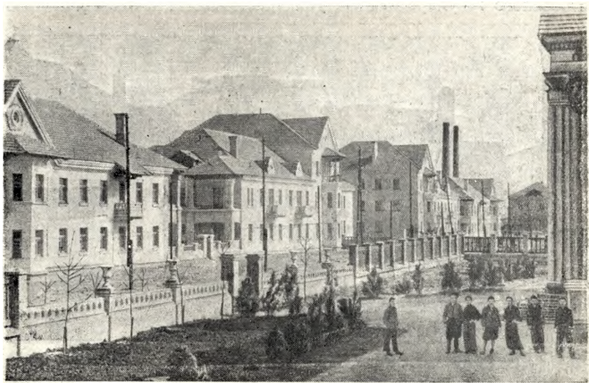
Жилые дома для строителей Каховской ГЭС по улице Ленина в Новой Каховке.
