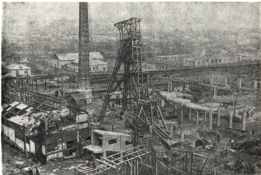
Общий вид разрушенной немецко-фашистскими оккупантами шахты «Голубовка» в Днѣпбассе. 1943 г.
