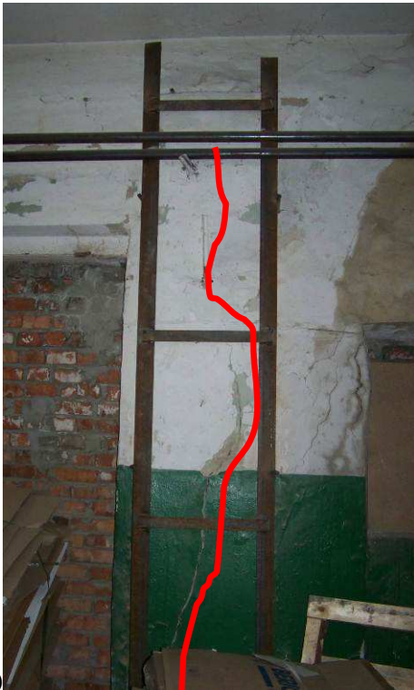
Фото 16. Утворення наскрізних вертикальних тріщин з шириною розкриття до 10 (!) мм в підсилених сталевими кутиками цегляних пілястрах в осях Е/6 (а) і Е/7 (б) (дефект Д6)
