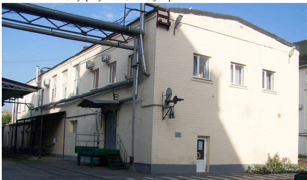
Фото 2. Загальний вигляд фасаду двоповерхової частини будівлі цеху фасування, складу тари в осях 9-1 та Е-Б
