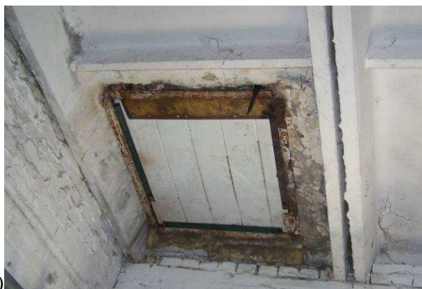
Фото 20. Непроєктні отвори у полиці з/б ребристих плит покриття в осях 9-15/А-Е (деф.Д10)
