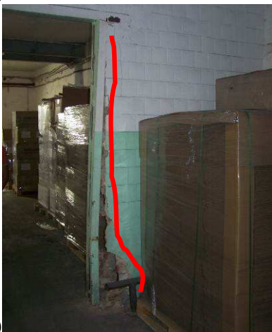
Фото 17. Руйнування цегляної кладки по периметру прорізів в осях 8-9/Г (а), 13-14/Е (б), Г-Е/8/1 (в-г), в результаті прямих механічних впливів під час руху електрокарів
