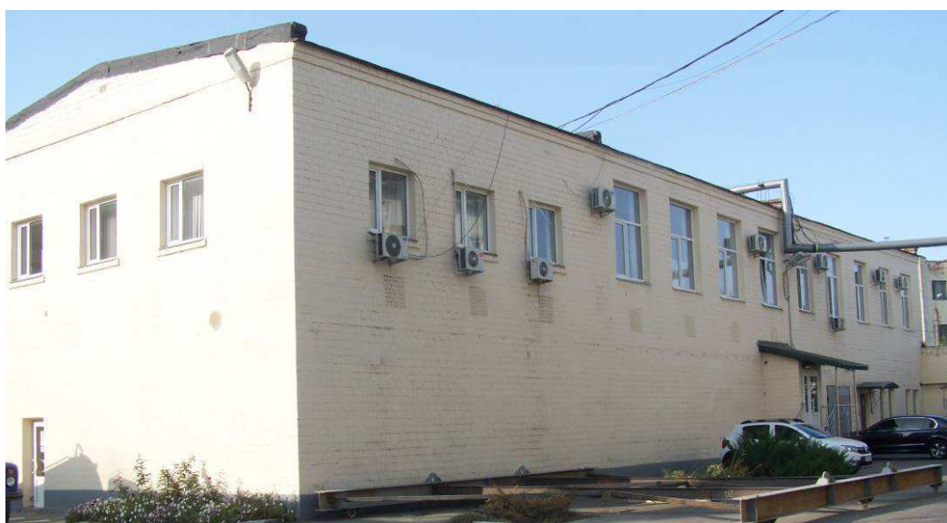
Фото 1. Загальний вигляд фасаду двоповерхової частини будівлі цеху фасування, складу тари в осях Е-Б та 1-9
