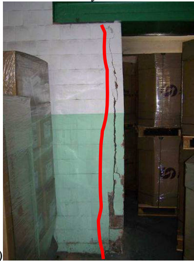
Фото 16. Утворення наскрізних вертикальних тріщин з шириною розкриття до 10 (!) мм в підсилених сталевими кутиками цегляних пілястрах в осях Е/6 (а) і Е/7 (б) (дефект Д6)
