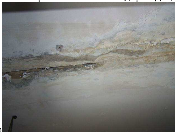
Фото 22. Сліди замокання по швах між пустотними плитами перекриття в осях 4-9/Б-Е (деф. Д12)
