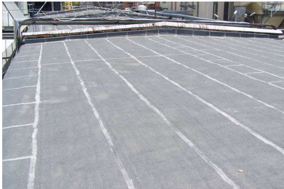
Фото 3. Загальний вигляд покрівлі будівлі цеху фасування, складу тари в осях 9-1
