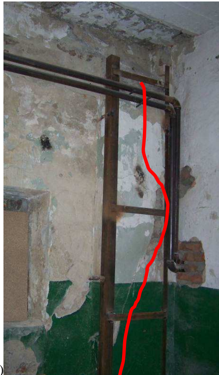
Фото 16. Утворення наскрізних вертикальних тріщин з шириною розкриття до 10 (!) мм в підсилених сталевими кутиками цегляних пілястрах в осях Е/6 (а) і Е/7 (б) (дефект Д6)
