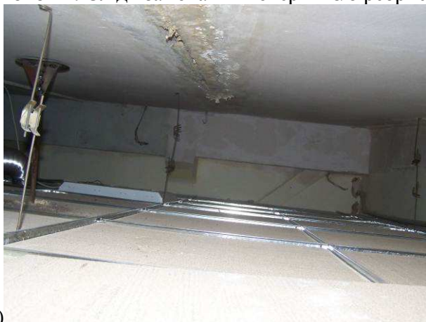
Фото 22. Сліди замокання по швах між пустотними плитами перекриття в осях 4-9/Б-Е (деф. Д12)
