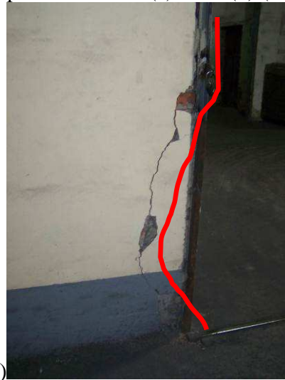
Фото 16. Утворення наскрізних вертикальних тріщин з шириною розкриття до 10 (!) мм в підсилених сталевими кутиками цегляних пілястрах в осях Е/6 (а) і Е/7 (б) (дефект Д6)
