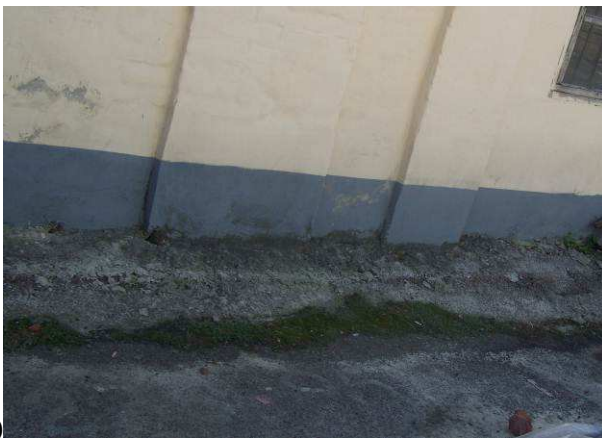
Фото 12. Недостатня ширина бетонного вимощення вздовж фасаду в осях 9-15/Е (деф. Д2)
