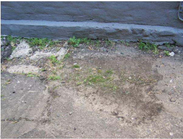
Фото 11. Наскрізні тріщини у асфальтобетонному вимощенні (а) та наявність безстічних майданчиків й контрукхилів вимощення (б) вздовж фасаду в осях 15-9/А (дефект Д1)
