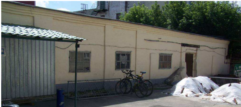
Фото 7. Загальний вигляд фасаду одноповерхової частини будівлі цеху фасування, складу тари в осях 9-15
