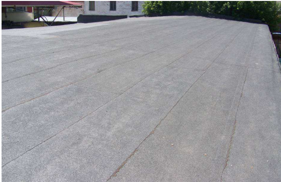
Фото 10. Загальний вигляд покрівлі будівлі цеху фасування, складу тари в осях 9-15
