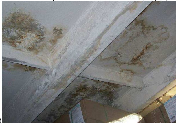
Фото 21. Сліди замокання поверхні з/б ребристих плит покриття в осях 9-15/А-Е (дефект Д11)
