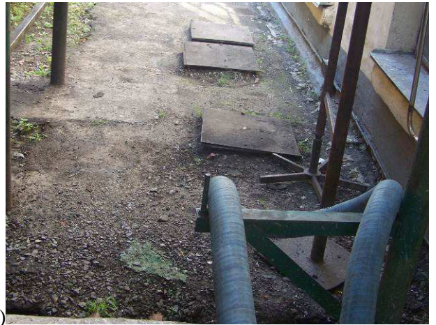
Фото 11. Наскрізні тріщини у асфальтобетонному вимощенні (а) та наявність безстічних майданчиків й контрукхилів вимощення (б) вздовж фасаду в осях 15-9/А (дефект Д1)
