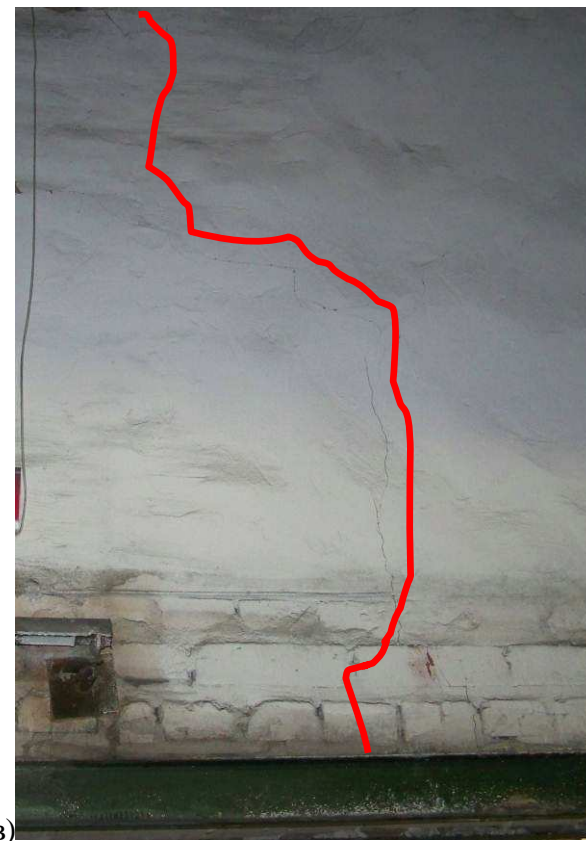
Фото 15. Утворення вертикальних тріщин в зовнішніх стінах в осях 4/Б (а), 8-9/Б (б), 14/Е (в), В-Г/15 (г) (дефект Д5)
