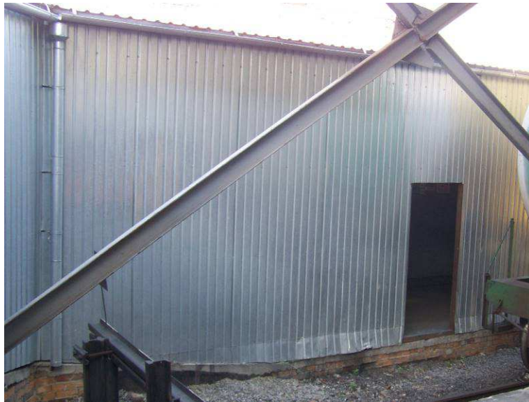
Фото 9. Загальний вигляд сталевому навісу в осях 15-13/А
