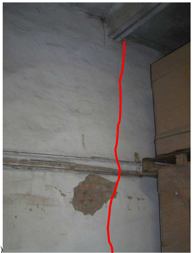
Фото 15. Утворення вертикальних тріщин в зовнішніх стінах в осях 4/Б (а), 8-9/Б (б), 14/Е (в), В-Г/15 (г) (дефект Д5)
