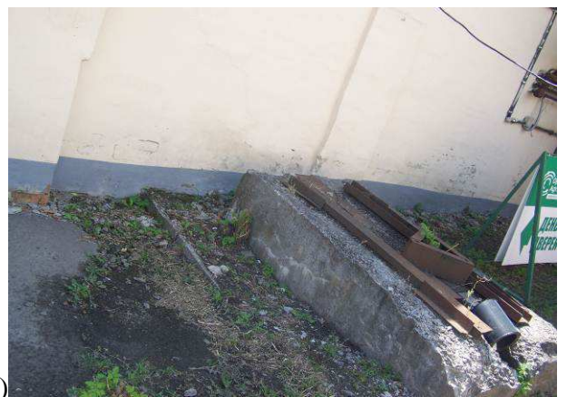
Фото 12. Недостатня ширина бетонного вимощення вздовж фасаду в осях 9-15/Е (деф. Д2)
