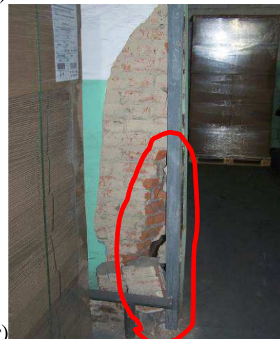
Фото 17. Руйнування цегляної кладки по периметру прорізів в осях 8-9/Г (а), 13-14/Е (б), Г-Е/8/1 (в-г), в результаті прямих механічних впливів під час руху електрокарів
