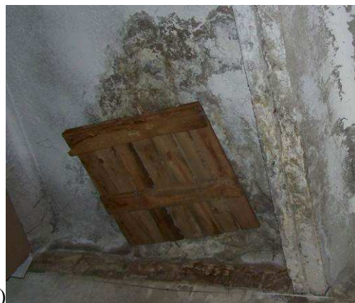
Фото 20. Непроєктні отвори у полиці з/б ребристих плит покриття в осях 9-15/А-Е (деф.Д10)
