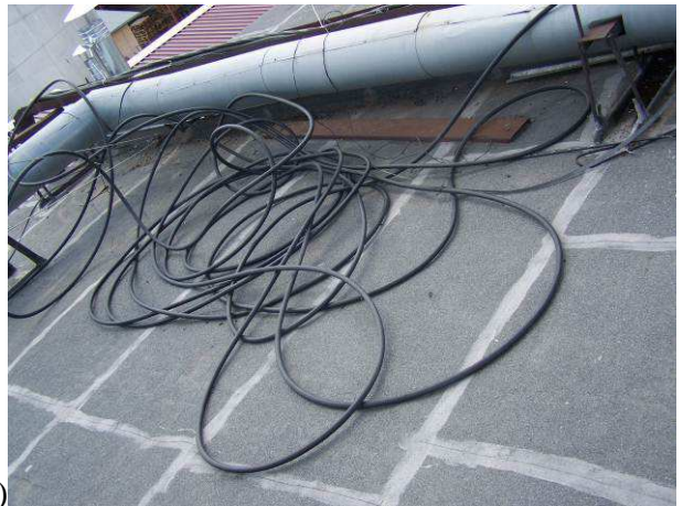
Фото 25. Наявність технологічних опор (а) та обладнання (б) на руберойдному килимі покрівлі в осях 1-9/Б-Е (дефект Д15)
