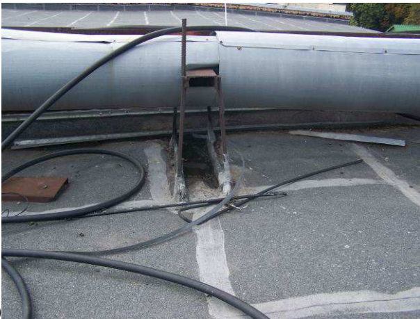
Фото 25. Наявність технологічних опор (а) та обладнання (б) на руберойдному килимі покрівлі в осях 1-9/Б-Е (дефект Д15)
