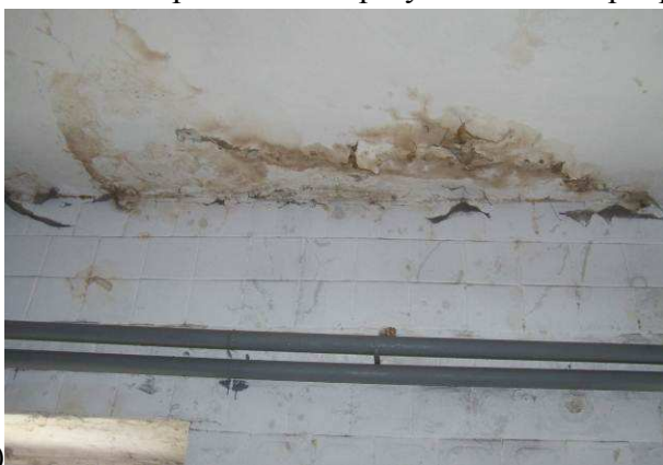
Фото 21. Сліди замокання поверхні з/б ребристих плит покриття в осях 9-15/А-Е (дефект Д11)
