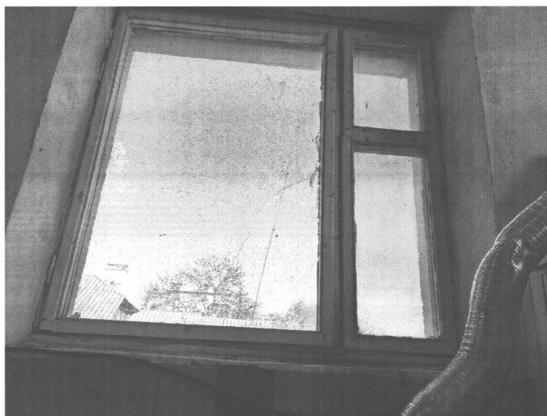
Фото 4. Незадовільний стан віконних блоків
