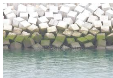
Рисунок 5.31 – Приклади влаштування хвилеломів
