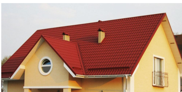
Рисунок 2.27 – Похилий дах житлової будівлі
