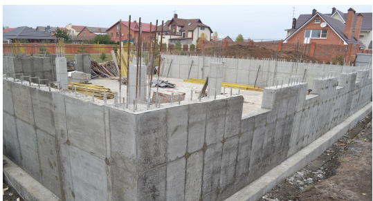
Рисунок 2.22 – Процес будівництва монолітних будинків
