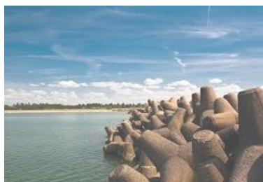
Рисунок 5.31 – Приклади влаштування хвилеломів
