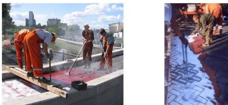
Рисунок 4.59 – Технологія влаштування покриття IMPRINT
