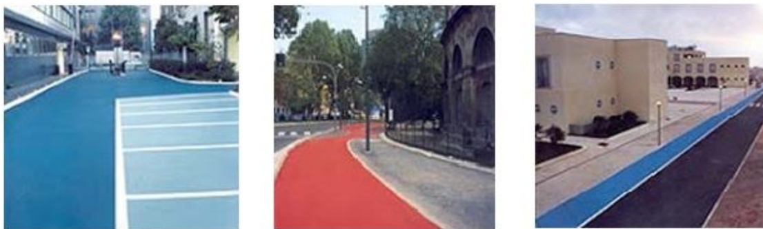
Рисунок 4.58 – Покриття з декоративного бетону
