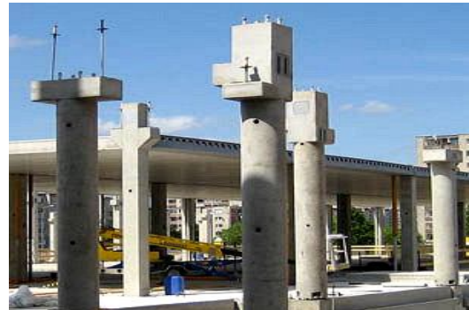
Рисунок 2.35 – Залізобетонні колони промислових будівель
