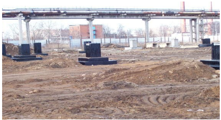
Рисунок 2.34 – Фундаменти промислових будівель
