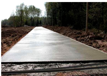
Рисунок 4.51– Укладання і вирівнювання поверхні цементобетонного покриття
