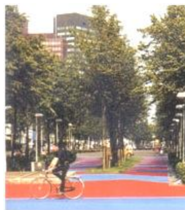
Рисунок 4.56 – Велосипедні доріжки, покриті акриловими емульсіями
