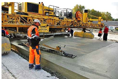
Рисунок 4.51– Укладання і вирівнювання поверхні цементобетонного покриття
