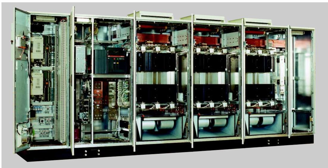
Рис. 9 Статическая система возбуждения типа UNITROL 5000 – внешний вид
