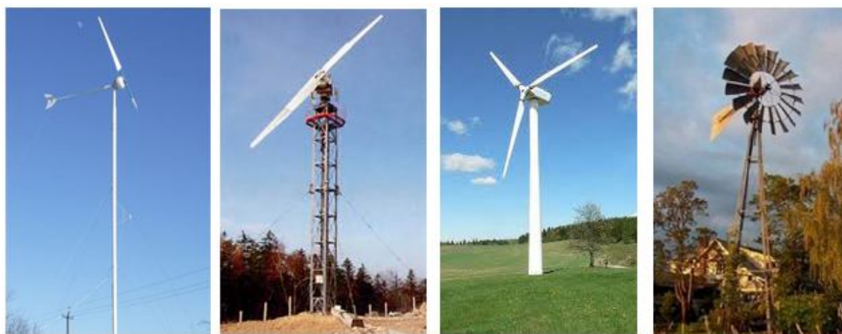
а) однолопатєва; б) дволопатєва; в) трилопатєва; г) багатолопатєва Рис. 8.4. ВЕУ з горизонтальною віссю обертання
