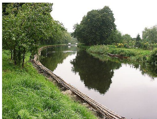
Рисунок 2.19 – Укріплення берегів фашинами
