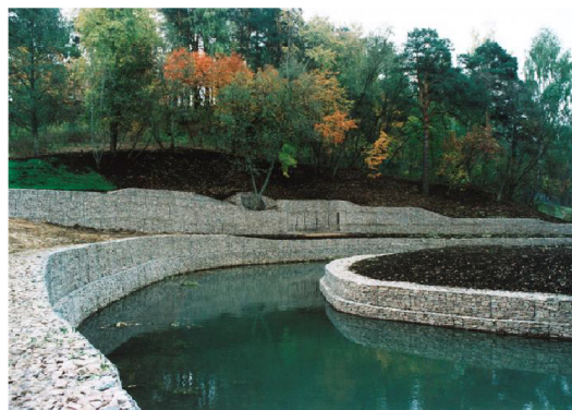
Рисунок 2.21 – Укріплення берегів габіонами
