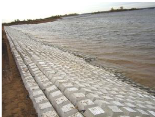
Рисунок 2.25 – Гнучкі бетонні мати
