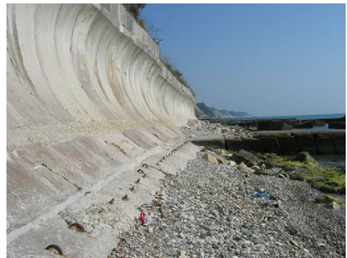
Рисунок 2.31 – Гравітаційна підпірна стінка з увігнутою передньою гранню
