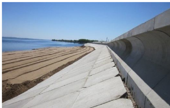
Рисунок 2.24 – Укріплення берегів залізобетонними плитами
